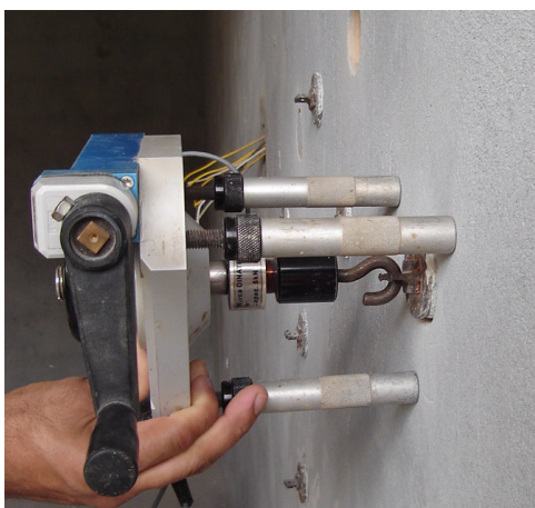
a) Vista do ensaio de aderência à tração.
