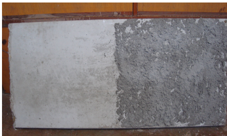
a) Sem chapisco e chapisco comum.
