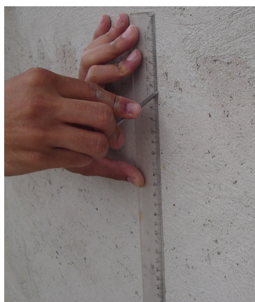
Foto 4.7 – Vista da realização do rasgo no revestimento.
