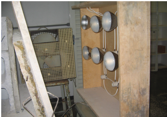
Figura 4.9 – Vista do painel térmico e do ventilador.
