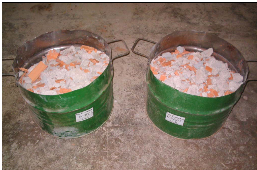
Fotografia 3.2 – Tambores de coleta de RSCD dispostos em um canteiro de obras.
