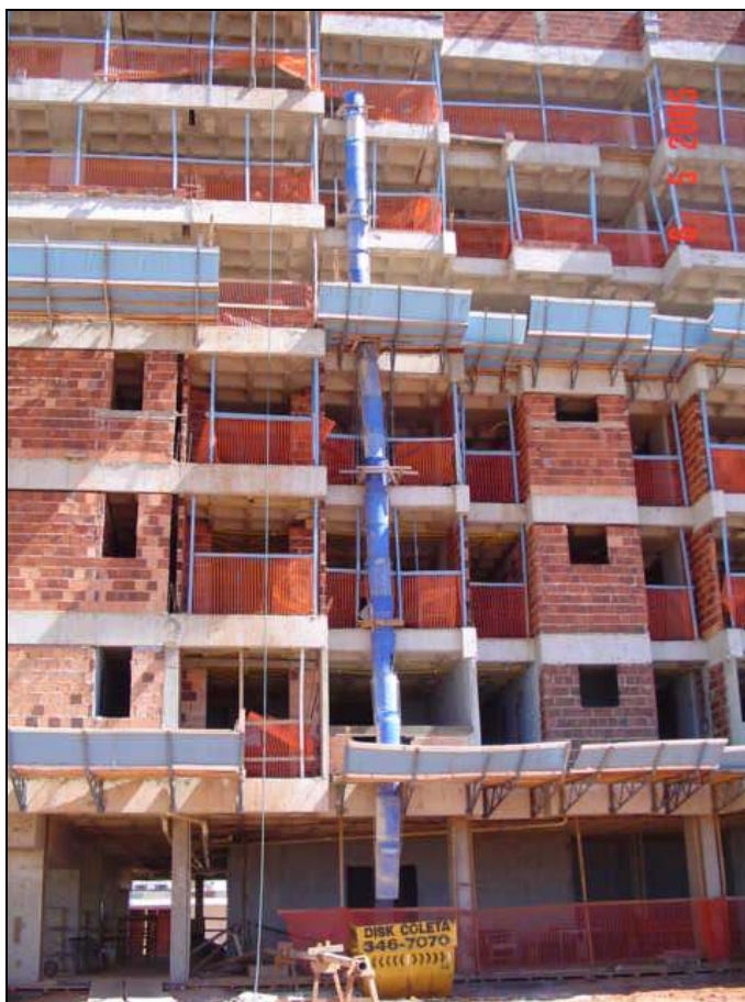
Fotografia 4.5 – Uso de tubo coletor no canteiro EC-11/CO-1.
