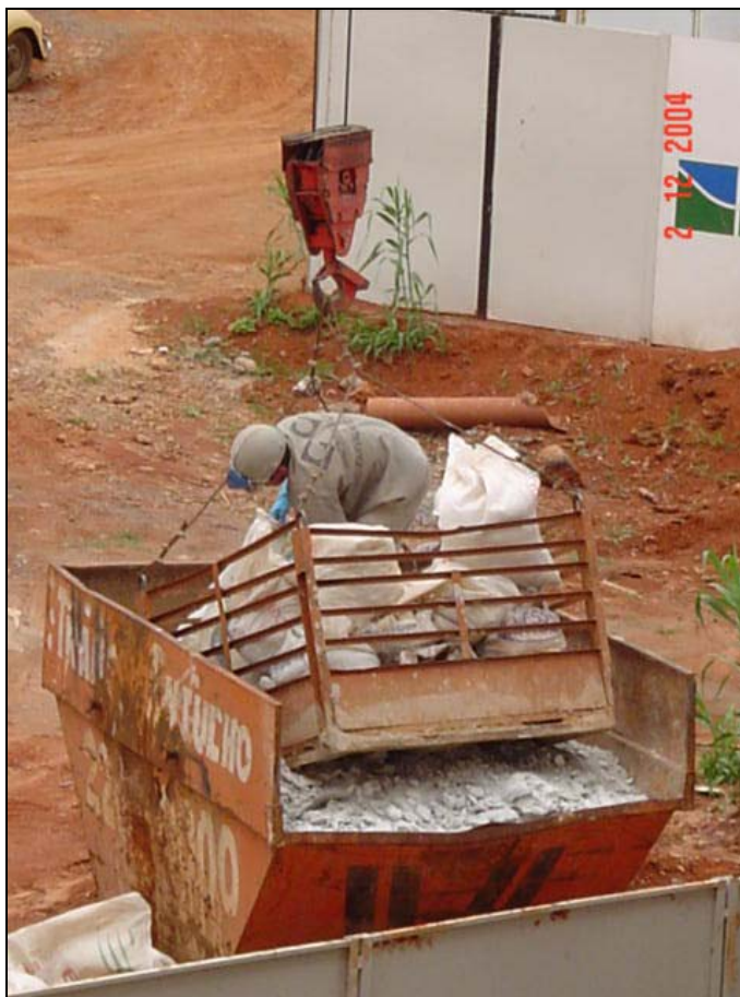
Fotografia 4.4 – Detalhe do transporte e da disposição do entulho no canteiro EC-1/CO-1.
