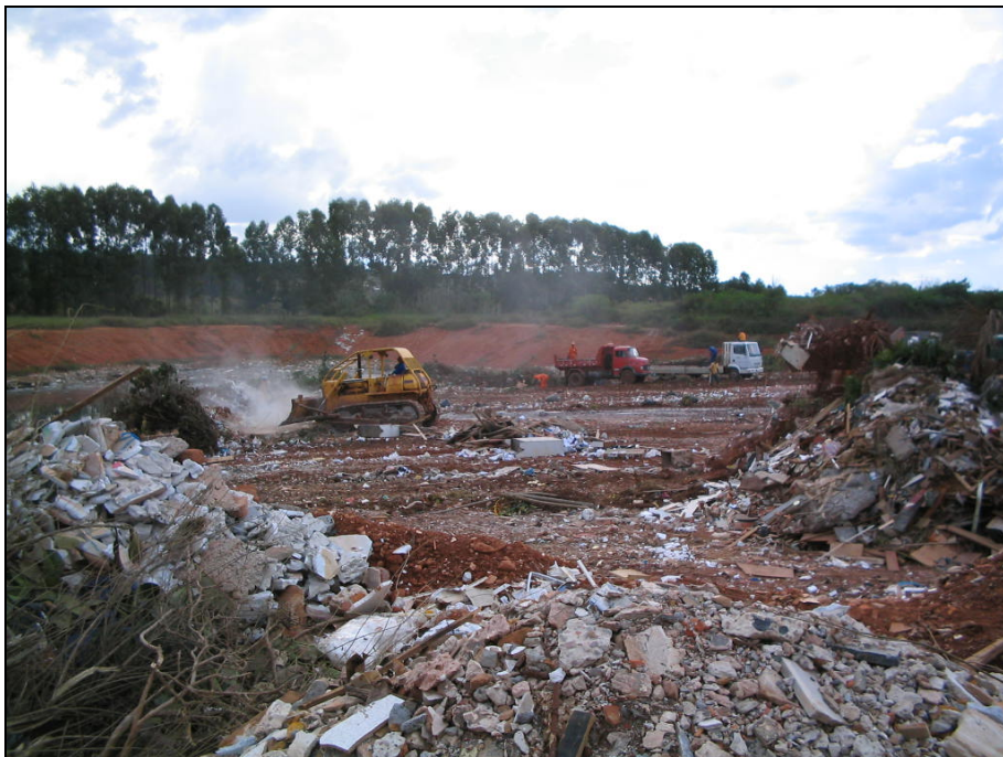
Fotografia 4.9 – Vista geral da área reservada à disposição do RSCD dentro do aterro do Jóquei Clube.
