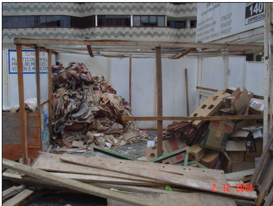
Fotografia 4.2 – Área de armazenagem temporário de RSCD no canteiro EC-1/CO-1.
