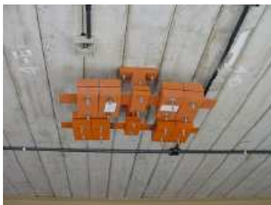
Figura 2.12. Atenuador Dinâmico Sintonizado (Battista e Varela, 2002).
