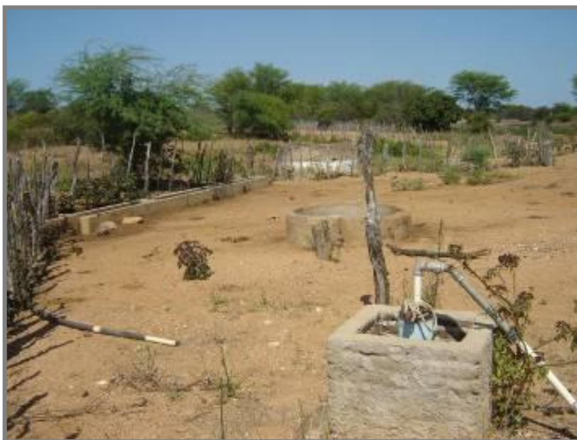
Figura 10 - Poço sem proteção, utilizado para consumo humano LOCAL
