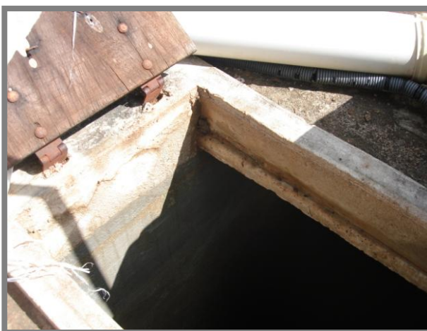
Figura 33 - Sistema com acesso à água que favorece a entrada de pequenos animais
