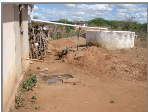
Figura 16 - Cisterna construída através do P1MC
