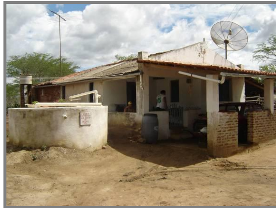
Figura 27 - Vista frontal de uma cisterna sem bombeamento elétrico com ausência de drenagem
