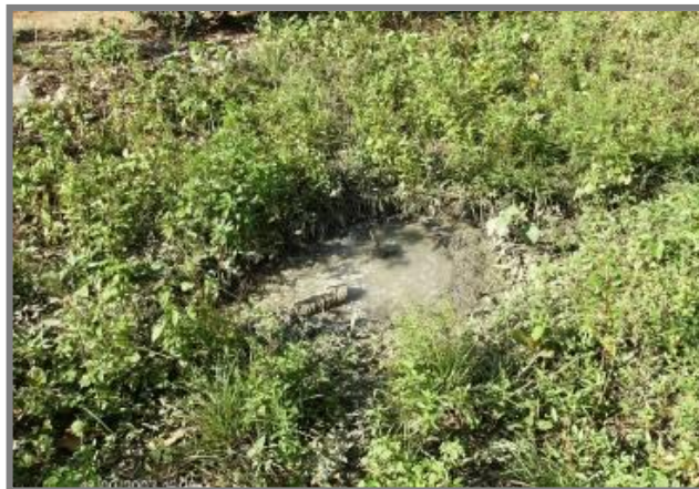
Figura 14 - Esgotos domésticos descartados próximo ao poço
