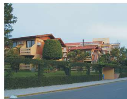
Figura 61: Vista geral do hotel, exemplar 10. Fonte: autor.
