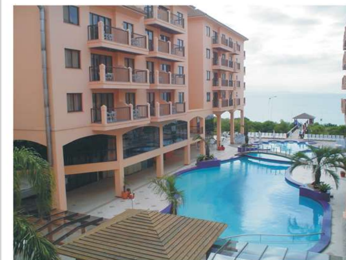
Figura 56: Vista lateral interna, exemplar 07. Fonte: autor.
