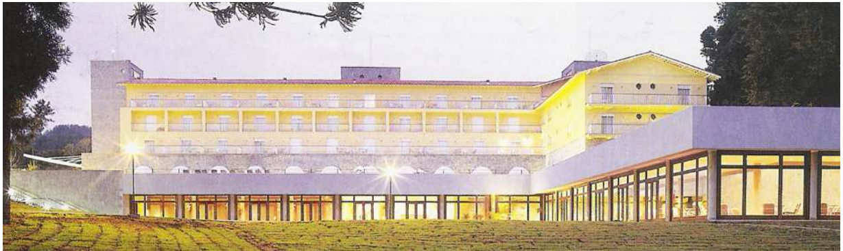
Figura 34: Grande Hotel de Campos do Jordão. Campos do Jordão, SP, Brasil. Arquiteto: Ricardo Chahin. Fonte: REVISTA PROJETO, n° 224, setembro de 1998, p.41.
