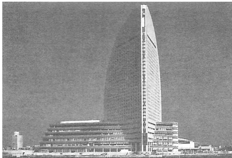
Figura 17: Yokohama Grand Inter-Continental Hotel, Yokohama, Japão. Arquitetos: Nikken Sekkei Fonte: LAWSON, 2003, p.162.
