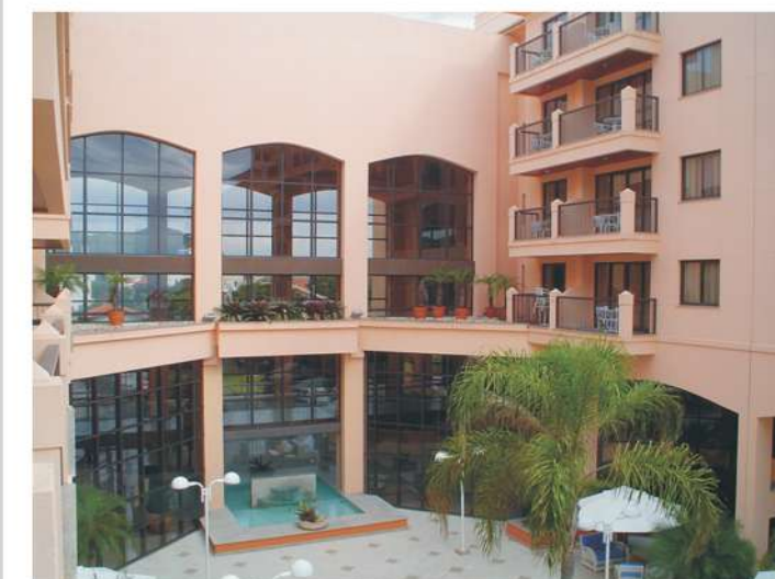
Figura 57: Vista interna átrio, exemplar 07. Fonte: autor.
