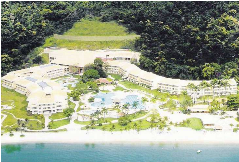
Figura 37: Blue Tree Park Hotel & Resort. Angra dos Reis, RJ, Brasil. Arquitetos: De Fournier & Associados Projetos e Urbanismo. Fonte: REVISTA PROJETO, nº 258, agosto de 2001, p.78.
