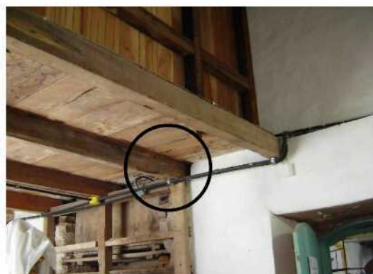
Ilustração 58 - Estrutura de ancoragem da tribuna. Foto da autora.
