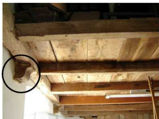
Ilustração 57 - Estrutura de ancoragem da tribuna. Foto - Angela do Valle.
