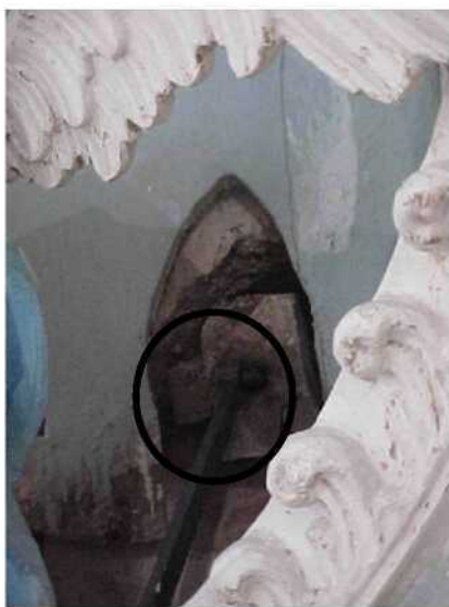
Ilustração 20 - Sistema secundário. Retábulo de São Miguel, Igreja Nossa Senhora das Necessidades. Foto da autora.
