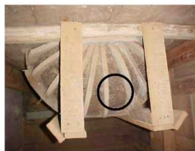
Ilustração 86 - Oxidação de folha metálica. Foto da autora. 2005.
