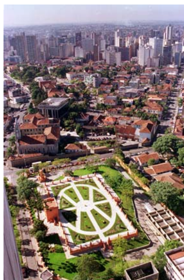
Ilustração 21 Vista Aérea Praça João Cândido
