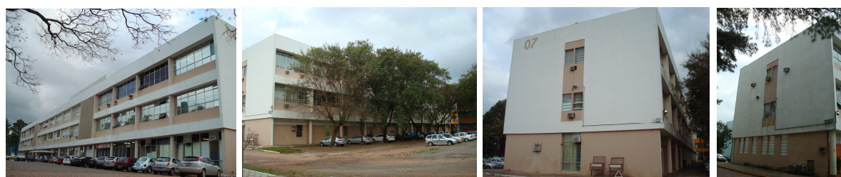
Figura 4.8 – Levantamento fotográfico das fachadas da edificação
