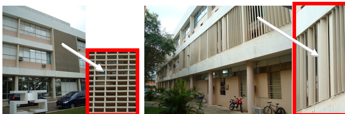
Figura 4.11 – Proteções solares nas fachadas oeste e leste, respectivamente
