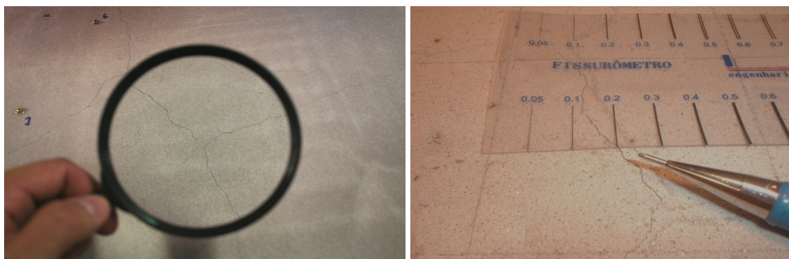
Figura 3.34 – Lupa e fissurômetro utilizados no levantamento das fissuras do revestimento.
