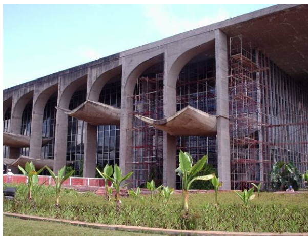
Figura 5.14 – Hidro-jateamento da fachada sul do Palácio da Justiça, em execução
