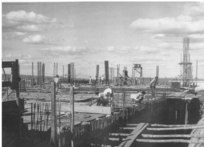
Figura 4.5 – Execução da 1ª. laje – Térreo (Divisão de Obras – MJ)
