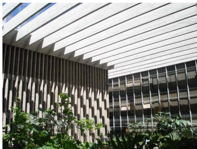
Figura 5.17 – Vigas do pergolado, jardim interno, após a recuperação
