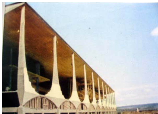
Figura 2.4 – Estrutura da fachada do Palácio da Alvorada em construção (Oríco, 1961)
