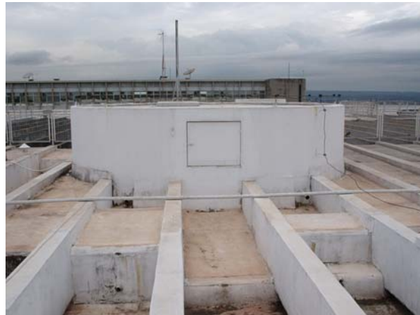
Figura 4.26 – Casa de máquina acima do nível da cobertura
