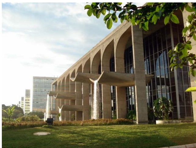
Figura 5.15 – Fachada principal do Palácio da Justiça após hidro-jateamento
