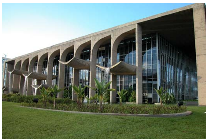
Figura 4.14 – Fachada principal, fachada sul do Palácio da Justiça
