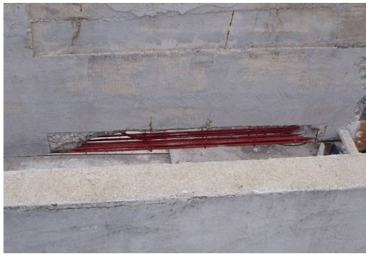
a) Armaduras com primer aplicado
