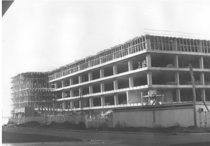
Figura 4.8 – Execução da 6ª. laje - Cobertura (Divisão de Obras – MJ)
