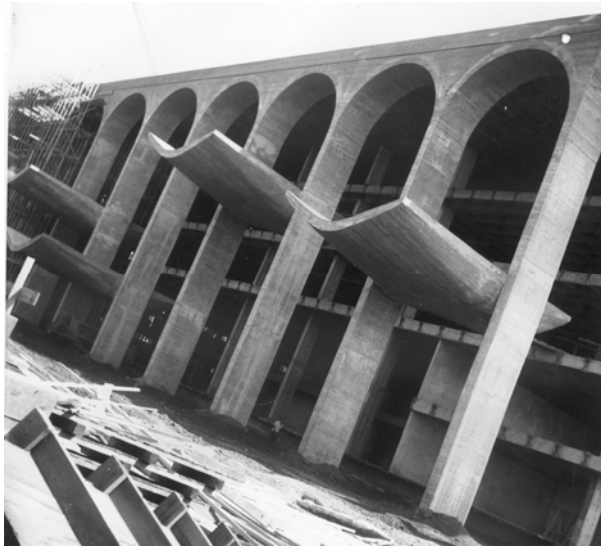
Figura 4.12 – Desforma dos arcos e cascatas, fachada principal (Divisão de Obras – MJ)
