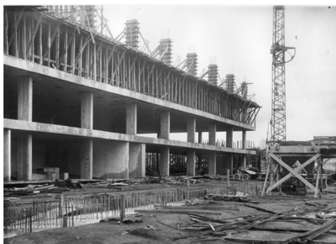
Figura 4.7 – Execução da 4ª. laje (Divisão de Obras – MJ)
