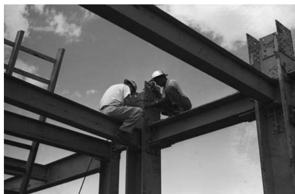
Figura 2.14 – Detalhe da estrutura das torres do Congresso Nacional (ArPDF)
