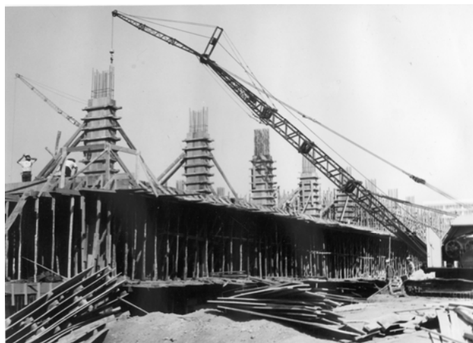
Figura 4.6 – Execução da 2ª. laje (Divisão de Obras – MJ)
