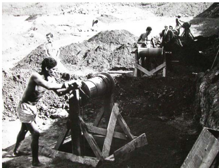
Figura 4.4 – Execução das fundações do Palácio da Justiça (Divisão de Obras - MJ)
