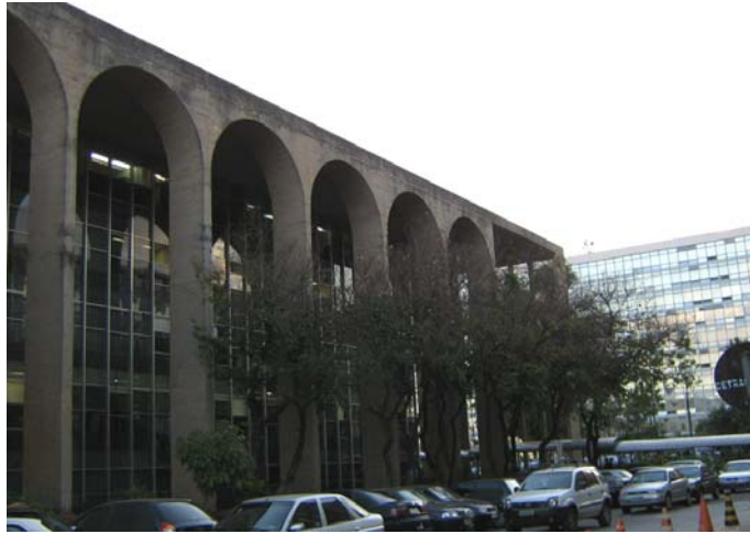
Figura 4.17 – Fachada norte do Palácio da Justiça
