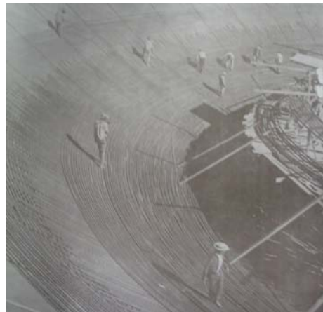
b) Armação da Cúpula da Câmara
