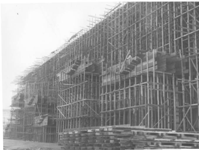
Figura 4.10 – Fôrmas das cascatas, fachada principal (Divisão de Obras – MJ)
