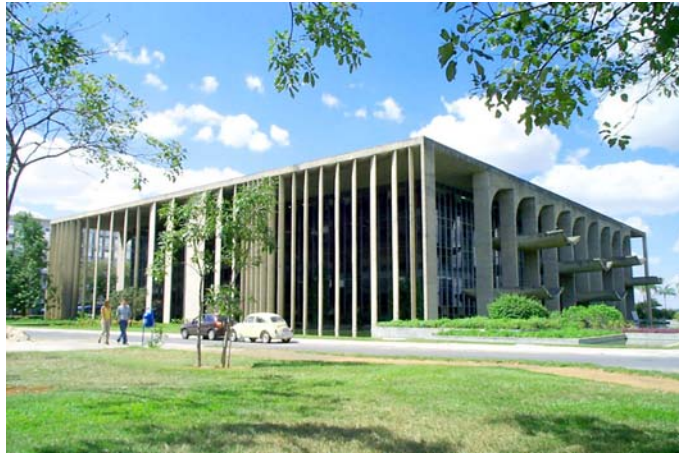
Figura 4.15 – Fachada oeste, “brise-soleil”, do Palácio da Justiça
