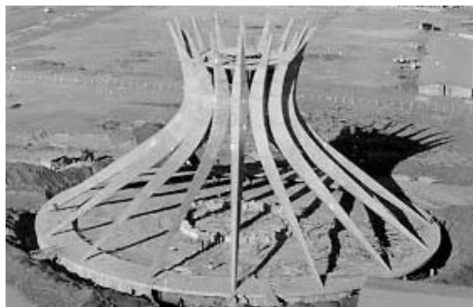
Figura 2.9 – Estrutura da Catedral de Brasília (Postal Colombo)
