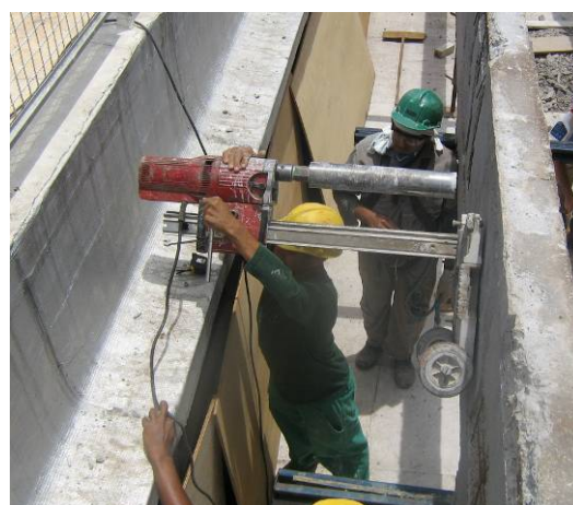
a) Extração em viga
