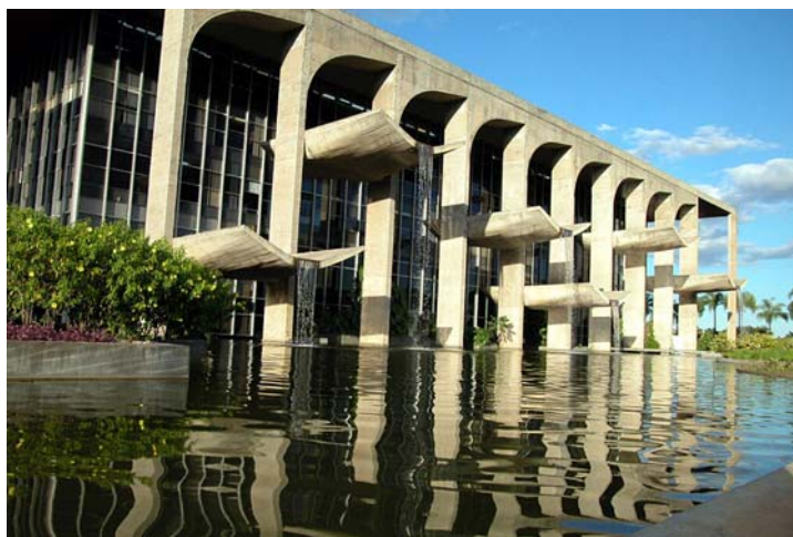
Figura 4.2 – Fachada principal do Palácio da Justiça (Isaac Amorim)
