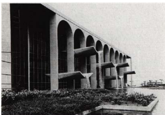
a) Fachada com os arcos plenos
