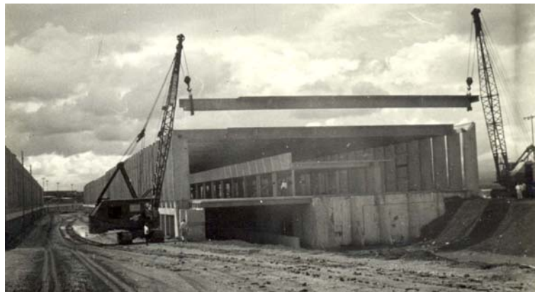
Figura 2.22 – Montagem das vigas pré-moldadas da cobertura do ICC (Cedoc-UnB)
