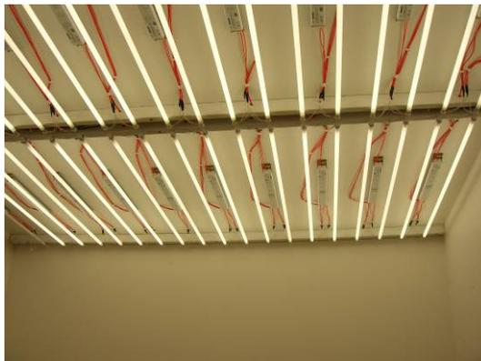
Figura 66. Cavidade das lâmpadas com acabamento branco e dois circuitos de lâmpadas T8.
