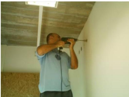
**Figura 68.** Aberturas para ventilação na parede lateral do Céu Artificial.
