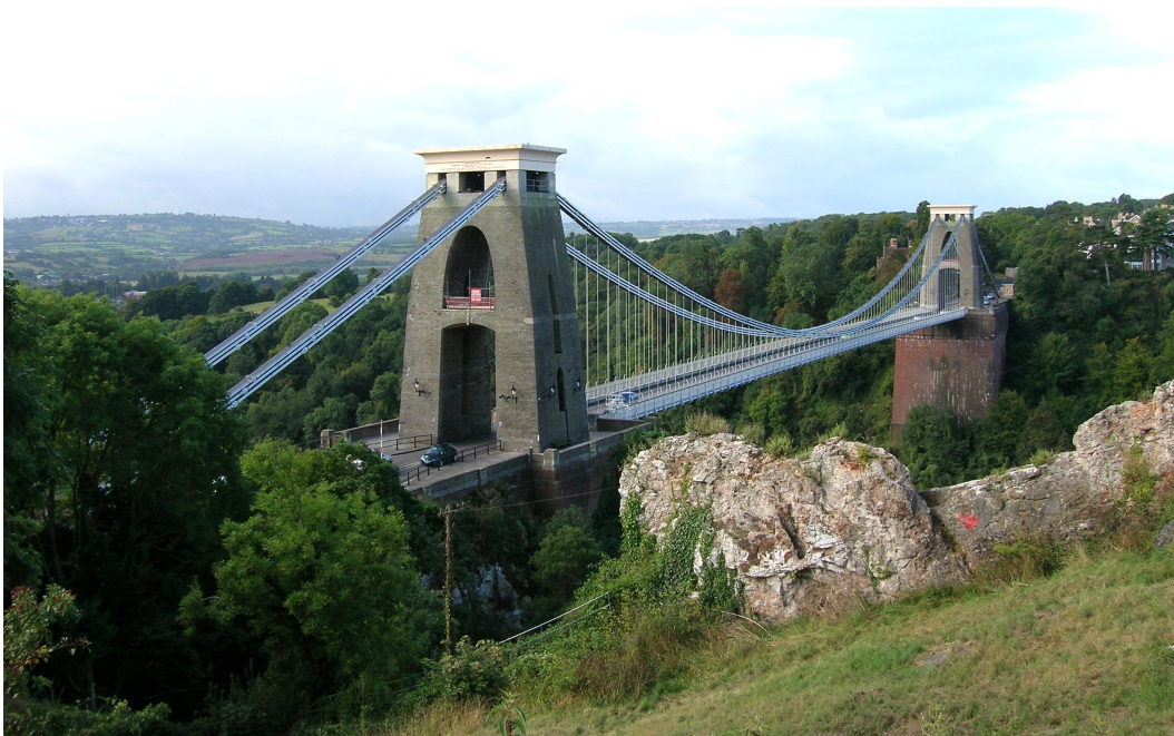
Figura 7. 2 – Ponte pênsil de Clifton – Bristol.
