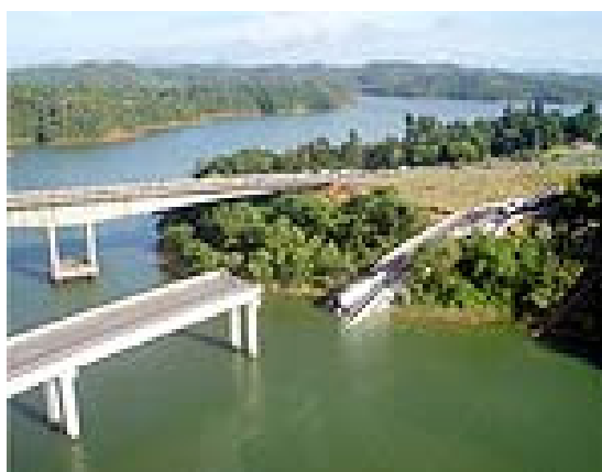
Figura 1. 7 – Desabamento de um trecho da ponte Capivari (Folhaonline, 2005).
