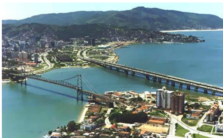
Figura 1. 2 - Ponte Hercílio Luz - Foto: Pedro Rocha.
