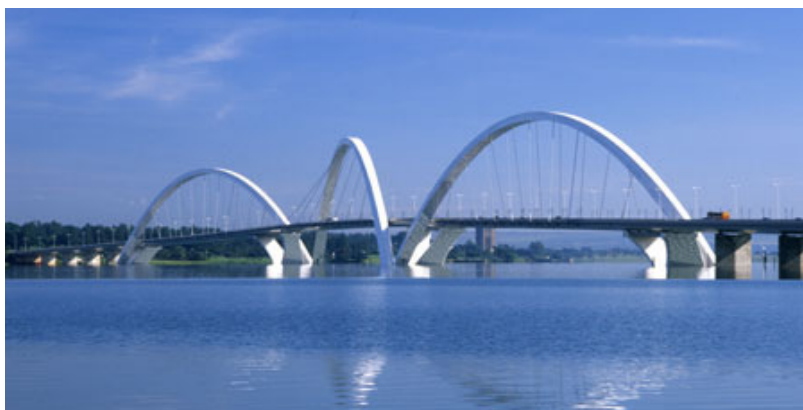
Figura 1. 1 - Ponte JK – Brasília, DF (2002).
