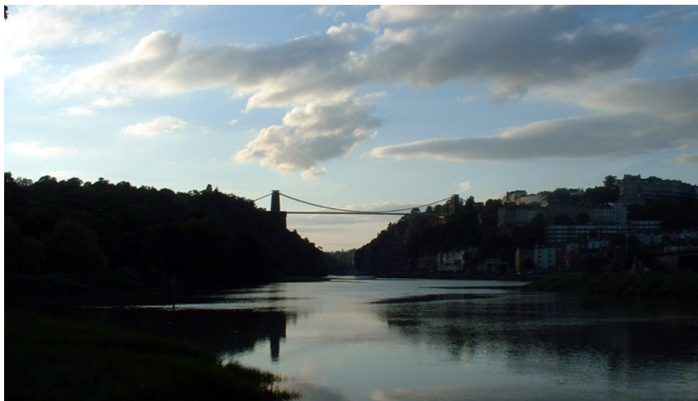
Figura 7. 1 – Ponte Pênsil de Clifton – Bristol.
