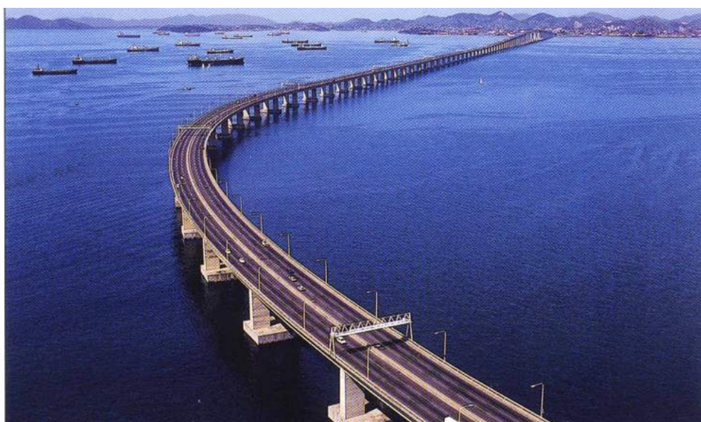
Figura 1. 3 - Ponte Rio-Niterói – (GALEB, 2002).
