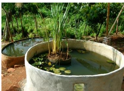
Tratamento biológico de efluente
