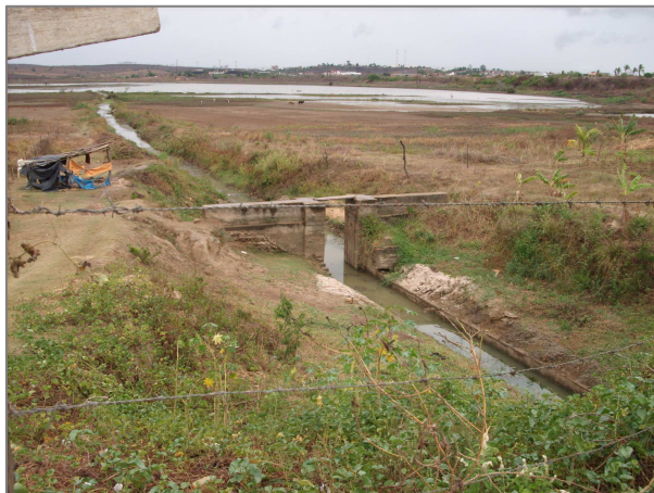
Figura 28: Canal na margem da Lagoa do Morro.
