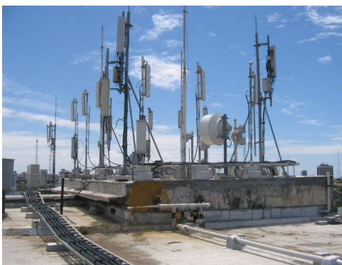
Figura 11. Compartilhamento de estrutura por multiusuário – Escola Politécnica da UFBA
