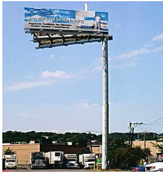
Figura 8. Mastro com letreiro camuflando as antenas de ERBs Fonte: http://www.kramerfirm.com/cell/index .
