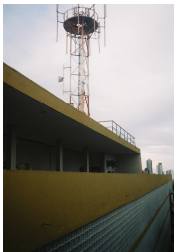
Figura 4. Tipo de ERB-Roof-Top Foto: Denize Francisca da Silva
