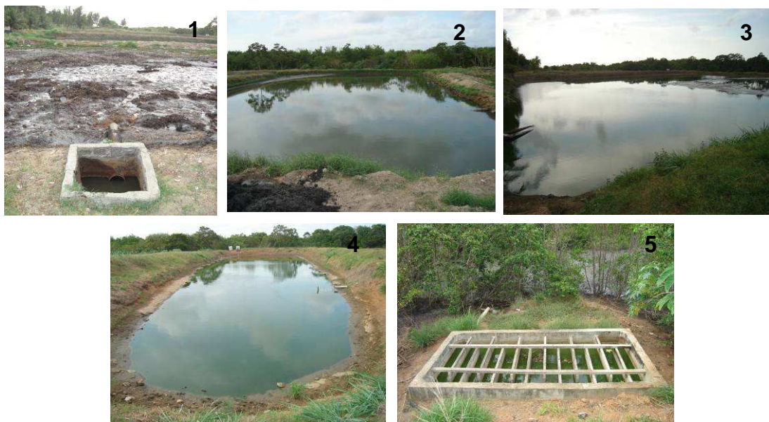
Figura 13: Lagoas em série monitoradas por Araújo et.al. (2008). 1 - Lagoa Anaeróbia I; 2 - Lagoa Anaeróbia II ; 3 - Lagoa Facultativa; 4 - Lagoa de Maturação; 5-Tanque de Contato.
