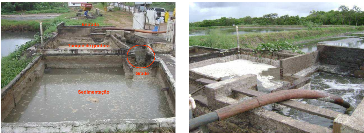
Figura 18: Tratamento preliminar da ETE da imunizadora mostrando a entrada no processo.
