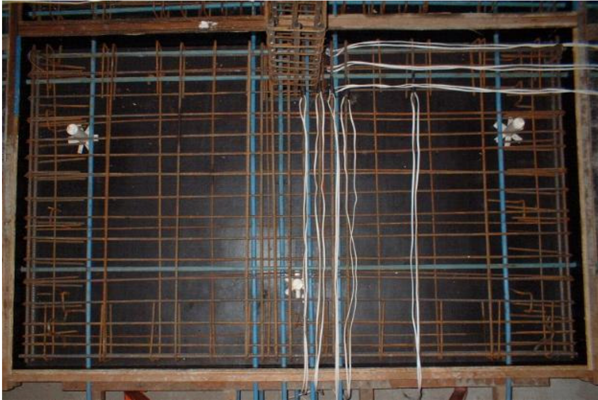
Figura 3.21 Fotografia da armadura da laje L12
