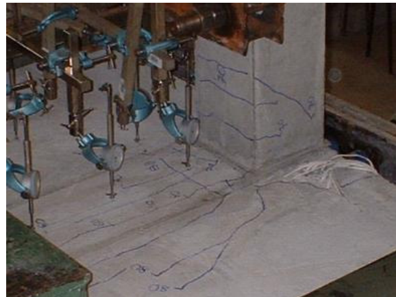
Primeiras fissuras: L2
