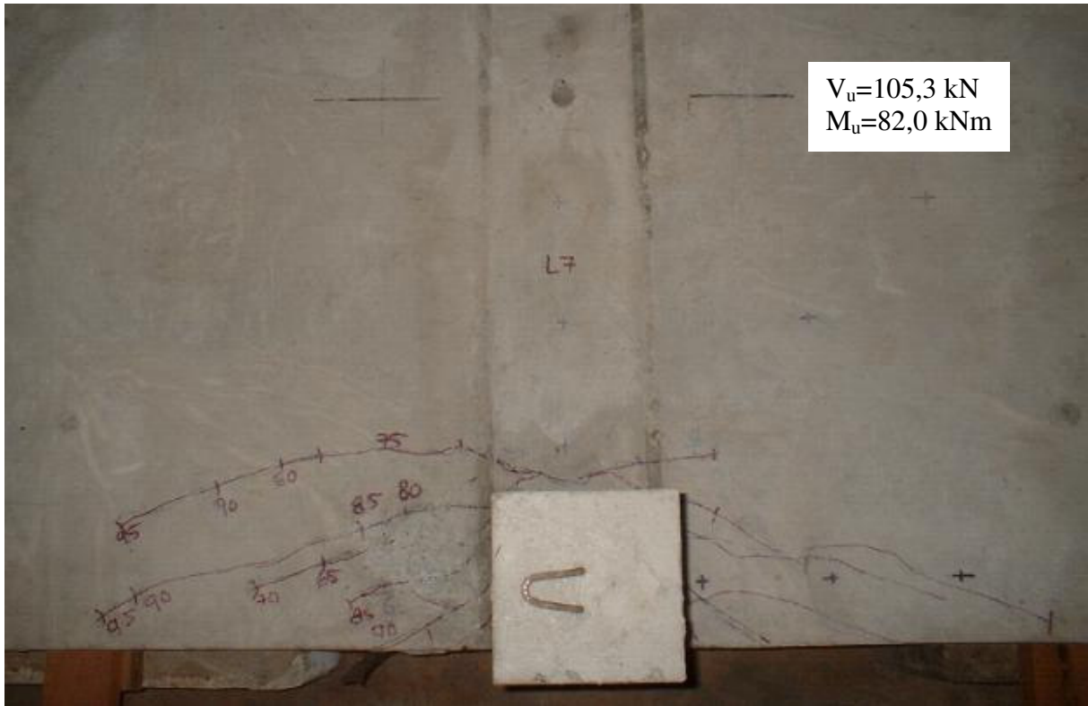
Figura 4.54 Ruptura da laje L7 em planta
