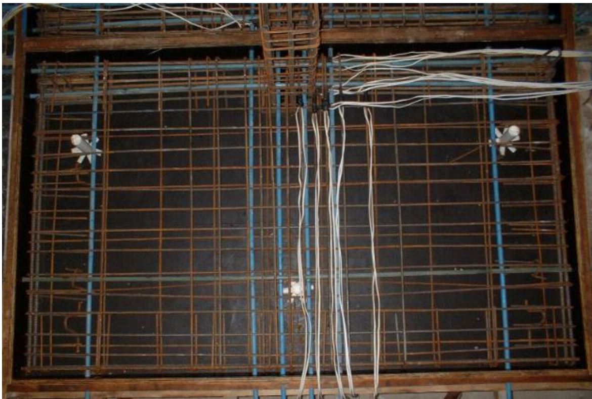
Figura 3.24 Fotografia da armadura da laje L15
