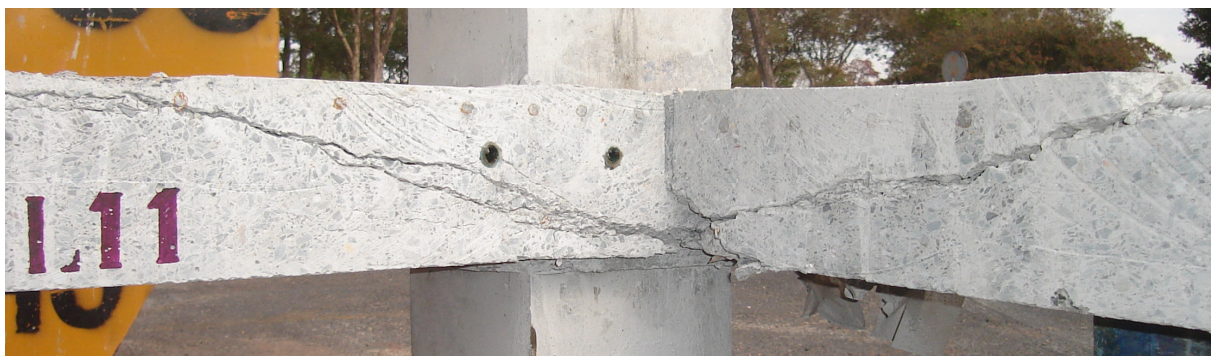
Figura 4.63 Seção transversal da ruptura laje L11
