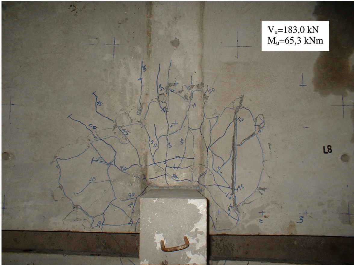
Figura 4.56 – Ruptura da laje do modelo L8.
