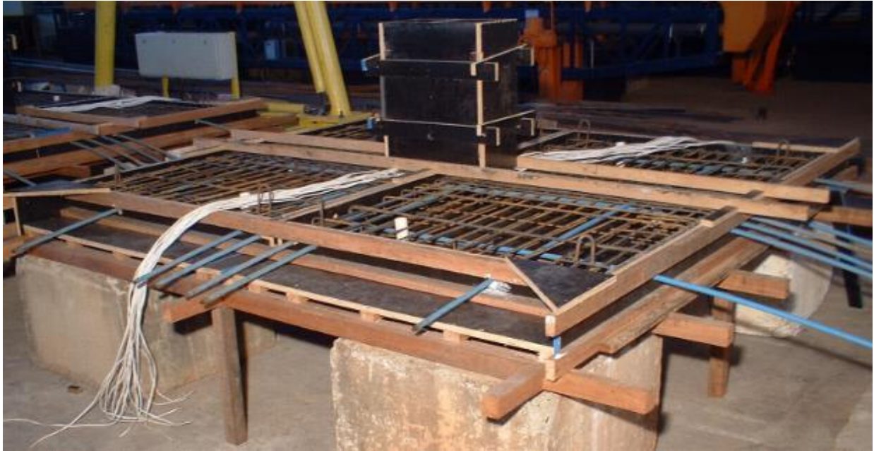
Figura 3.25 Fotografia das lajes prontas para serem concretadas
