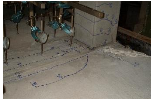
Primeiras fissuras: L4
