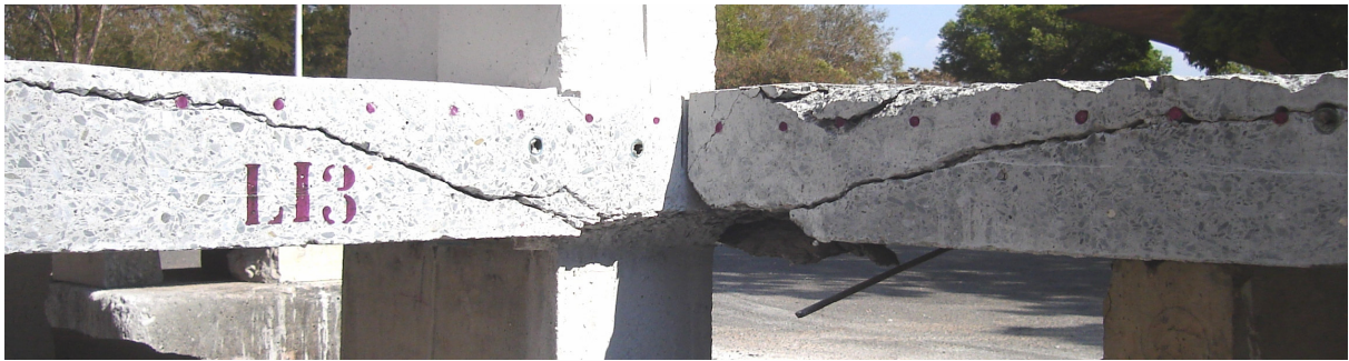
Figura 4.67 Seção transversal da ruptura laje L13
