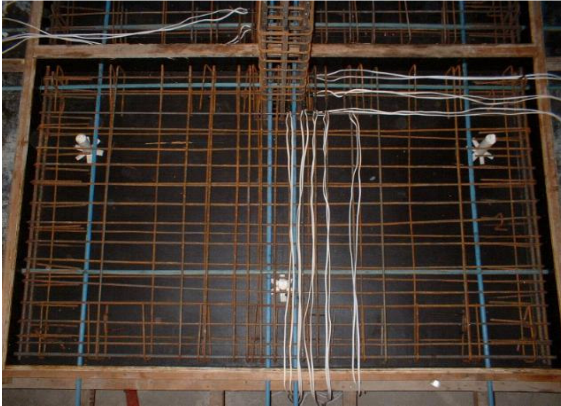
Figura 3.19 Fotografia representativa da armadura das lajes L8, L9 e L10
