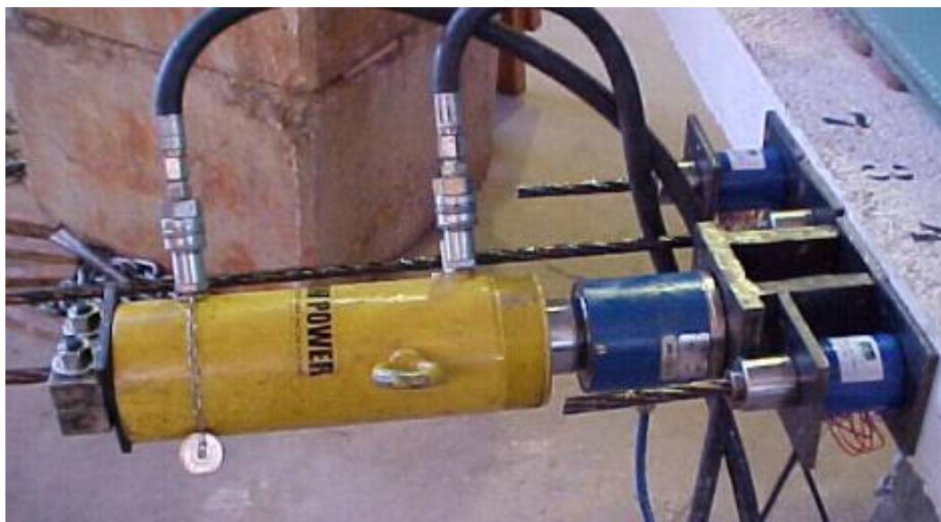
Figura 3.36 Sistema de protensão posicionado
