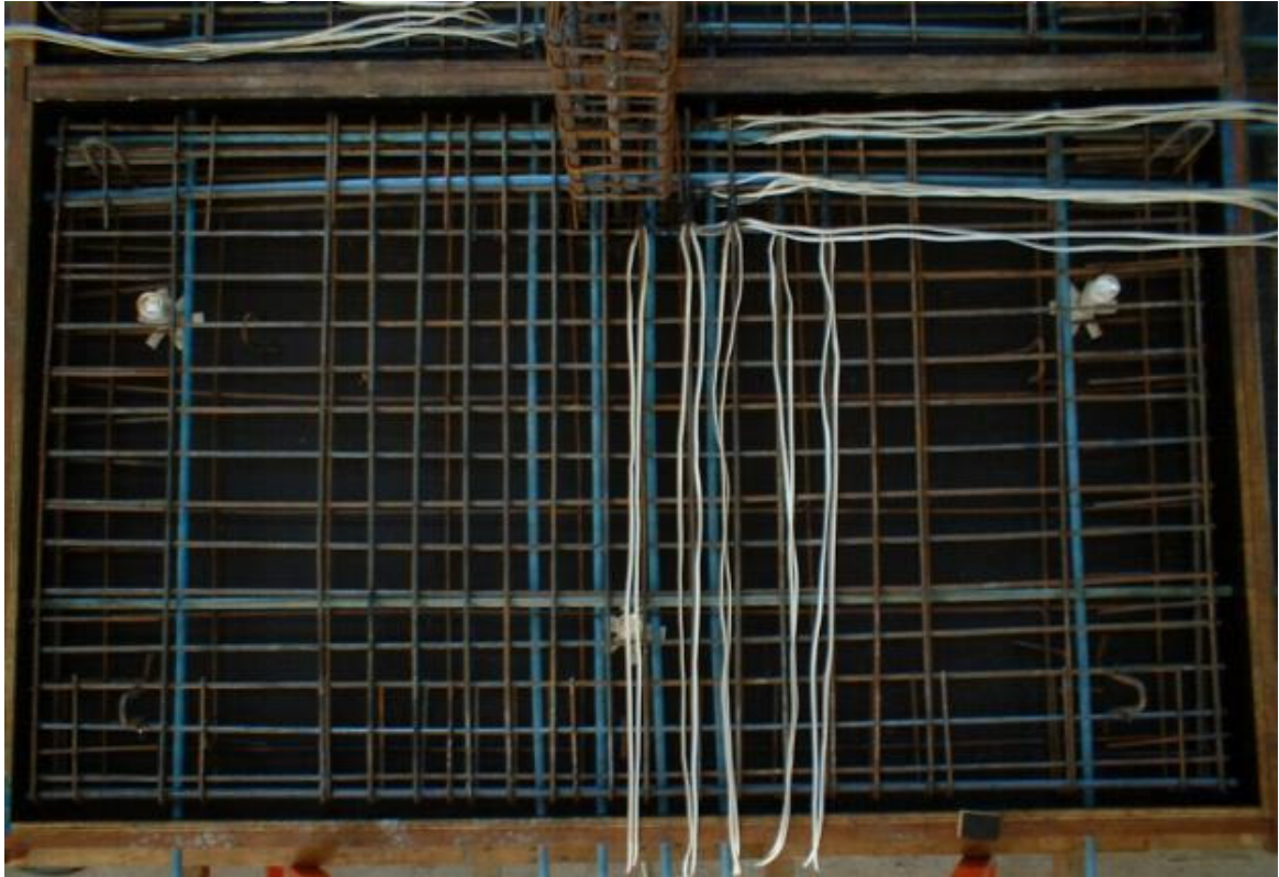
Figura 3.23 Fotografia da armadura da laje L14
