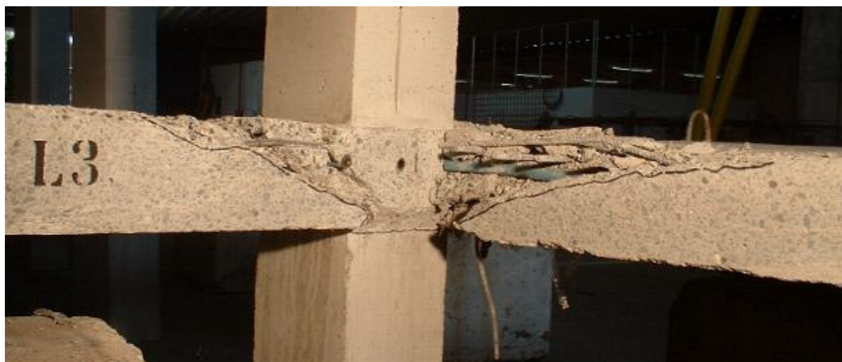
Figura 4.47 Seção transversal da ruptura laje L3
