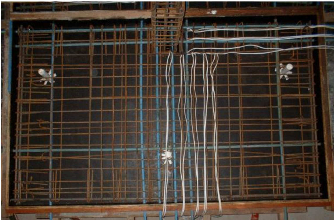
Figura 3.22 Fotografia da armadura da laje L13
