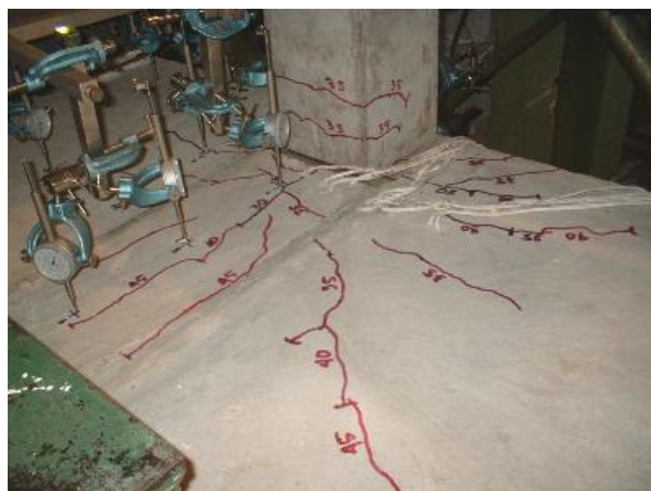
Primeiras fissuras L10
