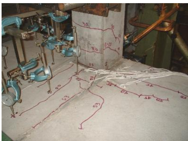
Primeiras fissuras L11
