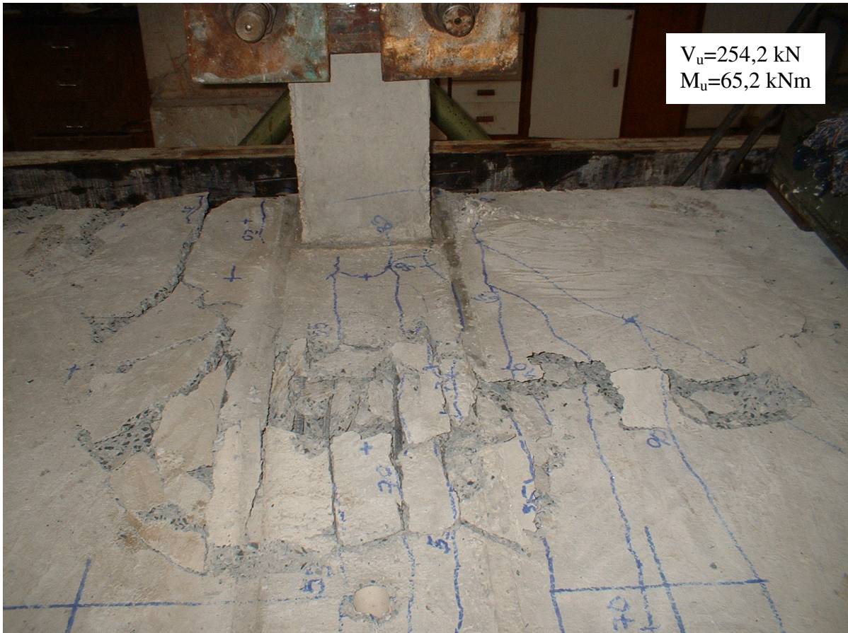
Figura 4.42 Ruptura da laje L1
