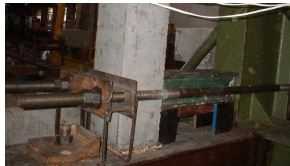
c) Fixação no pilar inferior
