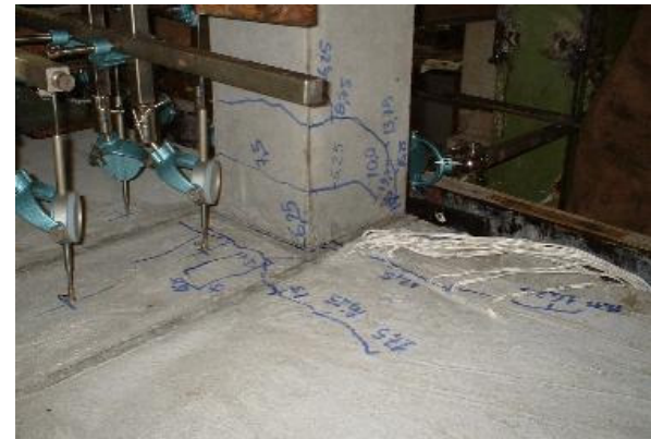
Primeiras fissuras: L6
