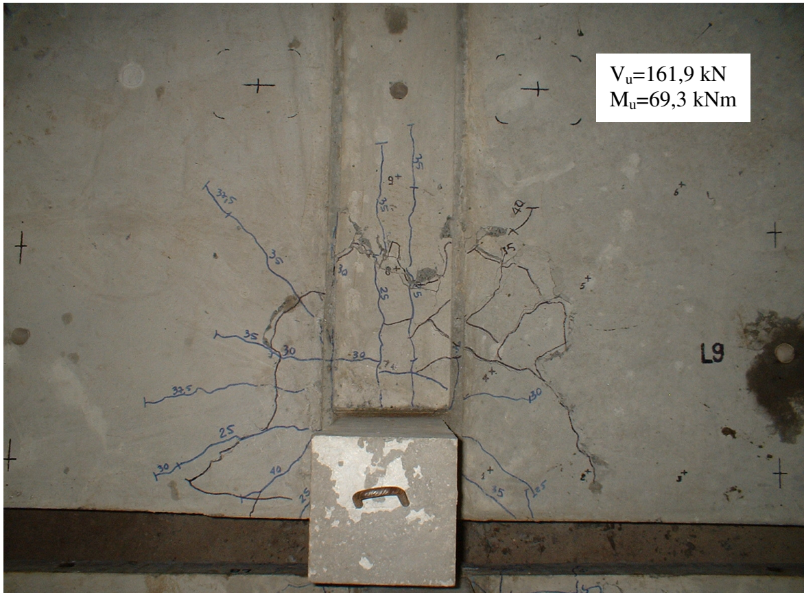
Figura 4.58 – Ruptura da laje do modelo L9.
