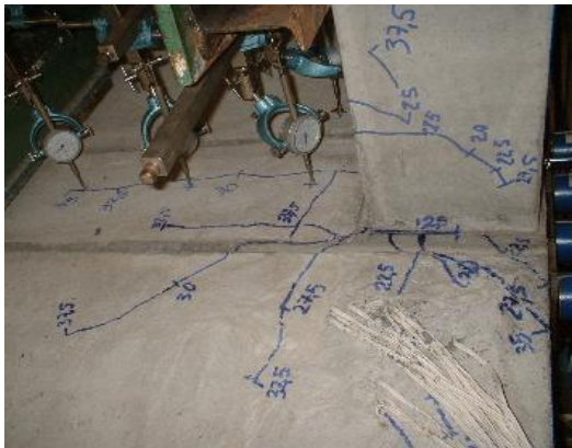
Primeiras fissuras: L5
