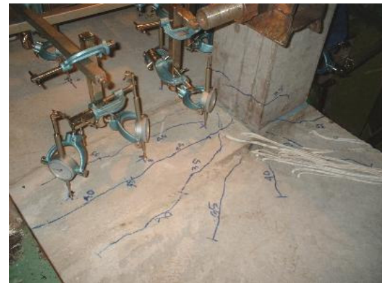
Primeiras fissuras: L8
