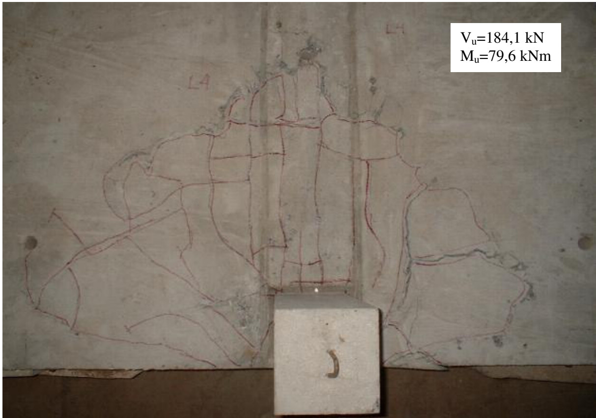
Figura 4.48 Ruptura da laje L4
