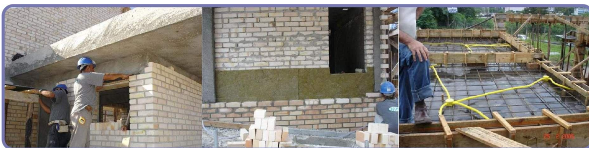
Figura 32: Imagens da Casa Eficiente em obras Fonte: CASA EFICIENTE, 2008
