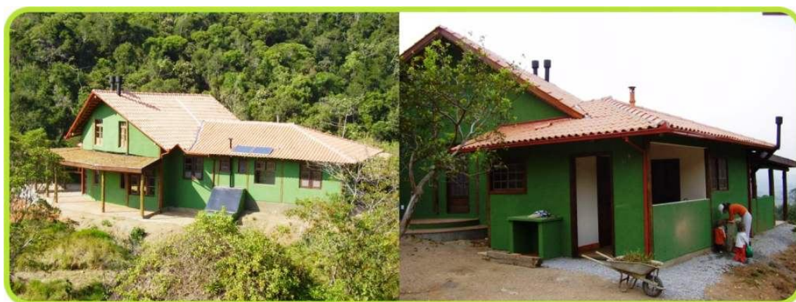
Figura 22: Frente e fundos da residência Abuhad – agosto de 2006
