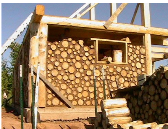
Figura 4: Casa construída com Cob Wood – autoconstrução dos Estados Unidos
