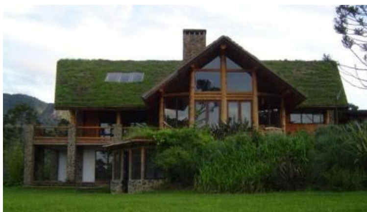
Figura 17: Foto lateral Curucaca – fachada Norte.
