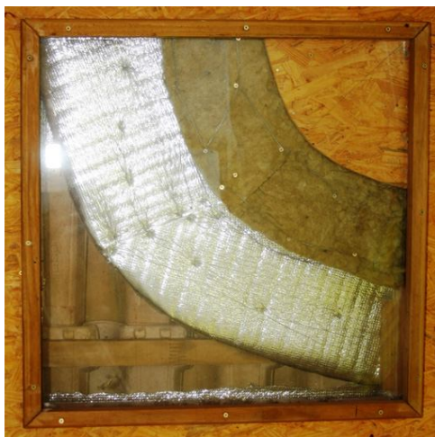
Figura 33: Cobertura com telha cerâmica + manta aluminizada + manta de lã de rocha + forro de OSB.
