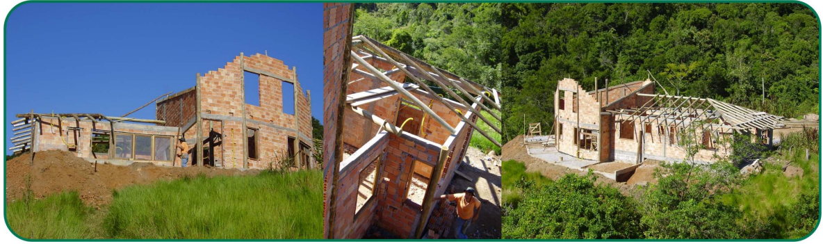
Figura 25: Residência Abuhad em obras – maio de 2006
