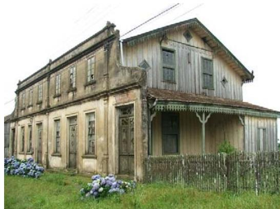
Fig. 23: Edificação em técnica construtiva mista, madeira e alvenaria de tijolos – Alto Paraguaçu, Itaiópolis. Fonte: arquivo do 11º SR IPHAN
