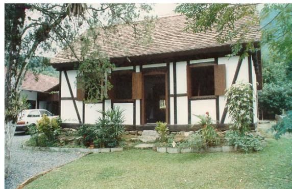
Fig.14: Casa construída em enxaimel e taipa - Pomerode. Fonte: Arquivo FCC
