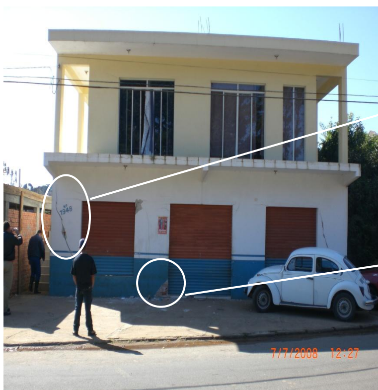
FIGURAS 2.12 E 2.13 – SUBSIDÊNCIA DE TERRENO CÁRSTICO EM RIO BRANCO DO SUL (PR) COM RECALQUE NA FUNDAÇÃO, TRINCAS E RACHADURAS NA EDIFICAÇÃO
