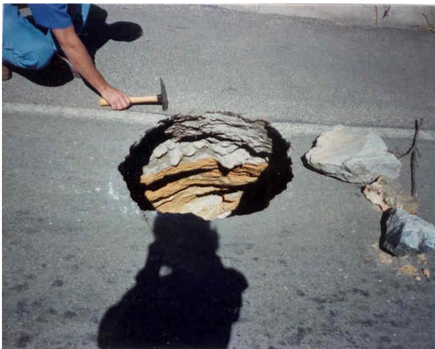
FIGURA 2.17 – COLAPSO DE SOLO NA RODOVIA PR 509 (ALMIRANTE TAMANDARÉ-COLOMBO) CAUSADO PELO TRÁFEGO PESADO (VIBRAÇÕES) FONTE: Mineropar (2005)
