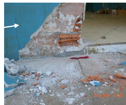
FIGURAS 2.12 E 2.13 – SUBSIDÊNCIA DE TERRENO CÁRSTICO EM RIO BRANCO DO SUL (PR) COM RECALQUE NA FUNDAÇÃO, TRINCAS E RACHADURAS NA EDIFICAÇÃO
