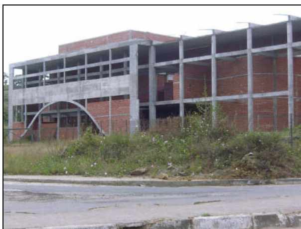
Figura 46 - Obra parada do Centro de Convenções. Itabuna, 2008. Foto: Lize Barroco (20/04/2008).
