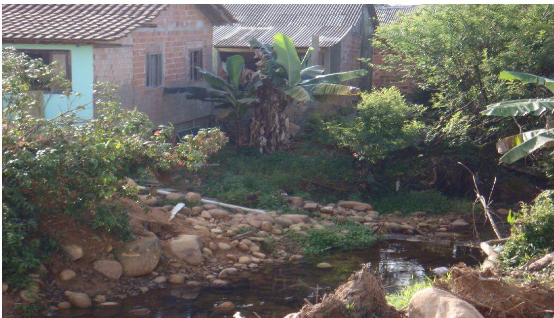
Figura 11: Casa construída em APP, no bairro Geórgia Paula, no Município de Garuva/SC.
