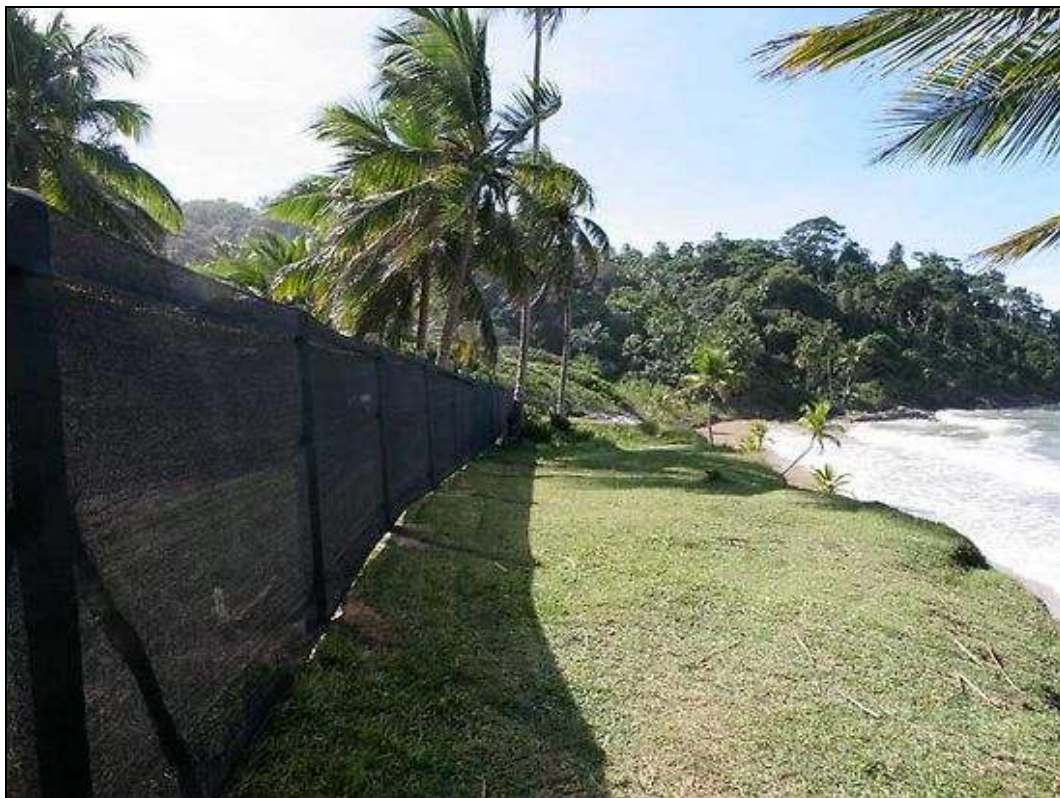
Figura 5 – Instalação de cerca na Praia da Engenhoca (2007).
