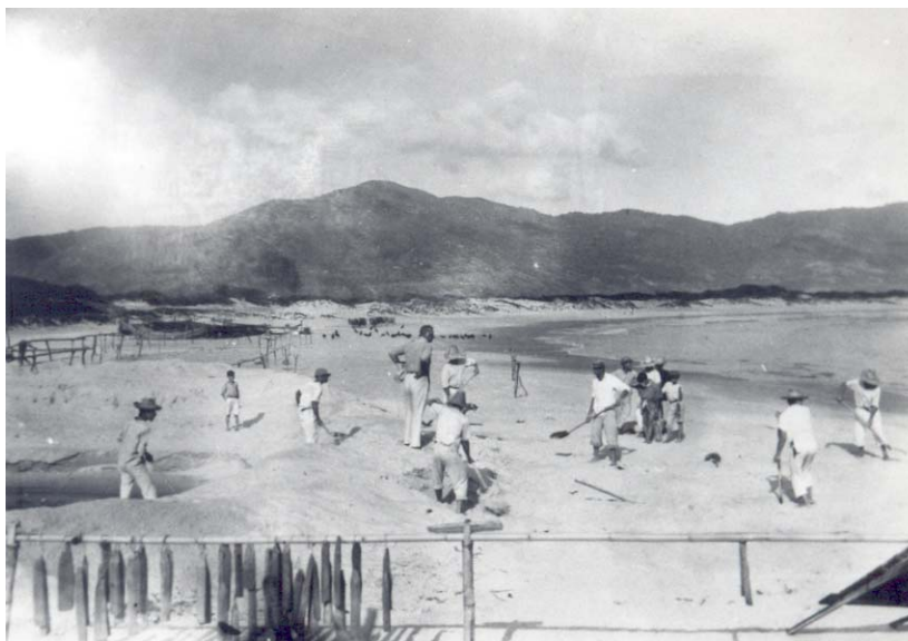
Figura 26 - Pescadores da Barra da Lagoa em mutirão construindo um molhe provisório com areia para limitar a entrada do canal no mar. Década de 1950.
