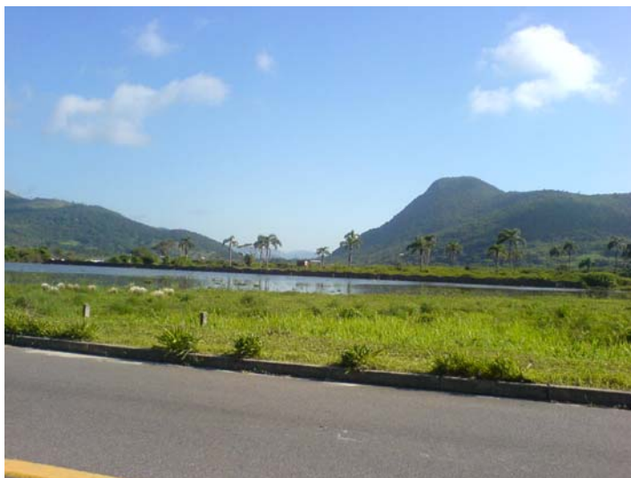
Figura 37 - Muro do Condomínio Velas em área alagada da antiga Lagoa das Capivaras. Fev/2008.
