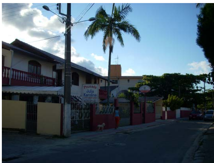
Figura 30 - Vista de uma das inúmeras novas edificações de serviços, uma pousada e outros para atendimento ao turista. Abr/08.
