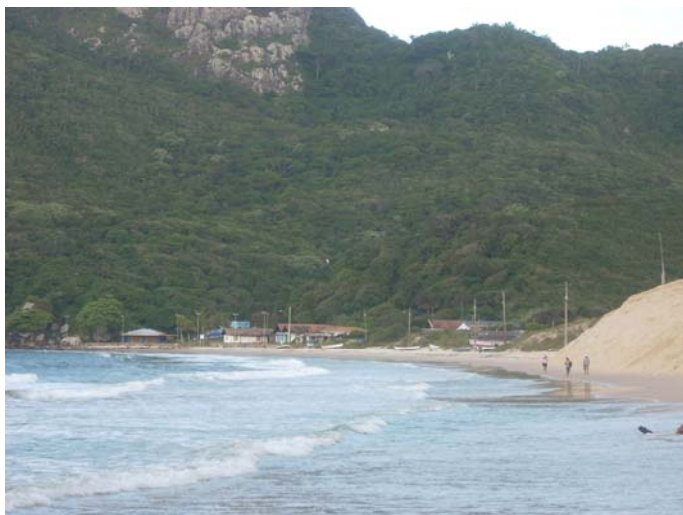
Figura 10 - Parte sul da praia ao lado da grande duna chegando ao mar, perto do Morro dos Ingleses. Nov/2008
