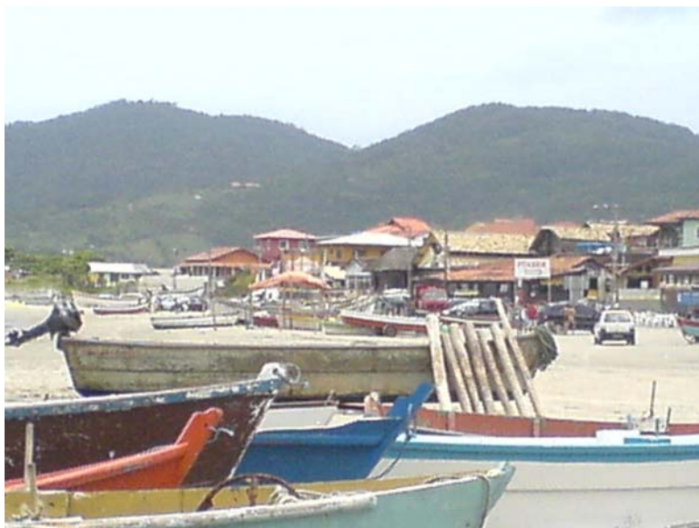
Figura 43 - Adensamento das edificações na Vila do Pântano do Sul, vista desde a praia. Mar/2008.
