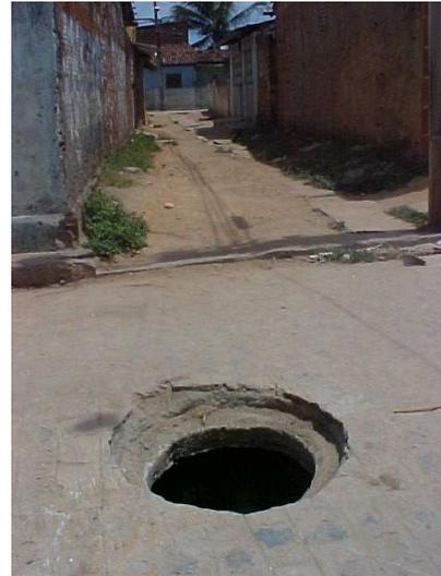
Figura 30: SES Santa Terezinha – Poço de visita danificado (2002).
