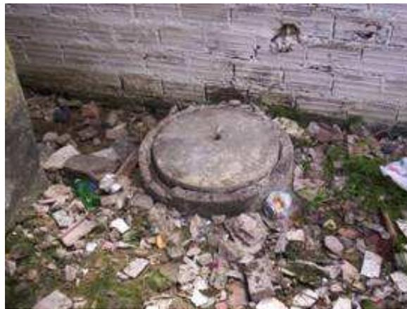
Figura 68: Caixa de inspeção limpa após a conclusão do serviço de desobstrução das tubulações.
