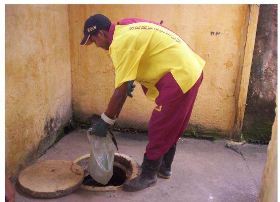
Figura 65: Equipe realizando a remoção de material indevido do interior da caixa de inspeção com a concha e coletando em sacola plástica.
