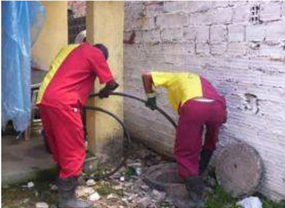
Figura 66: Equipe realizando a desobstrução das tubulações com a mangueira Pead.
