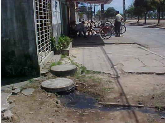
Figura 25: SES Chié – Obstrução do ramal coletor (2002).
