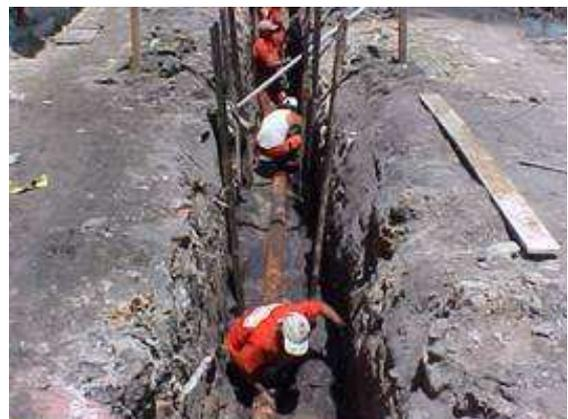
Figura 47: Implantação de rede coletora de esgoto (2003).
