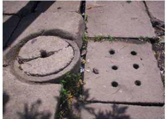
Figura 77: Rua Benício Dias. Caixa de inspeção com tampa danificada.
