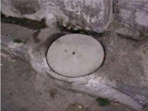
Figura 78: Rua Arsênio Tavares. Caixa de inspeção com nova tampa.
