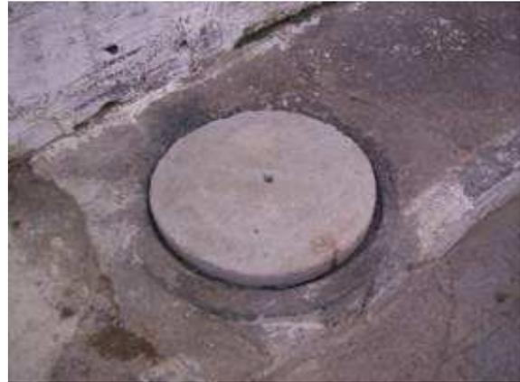
Figura 79: Rua Arsênio Tavares. Caixa de inspeção com nova tampa.
