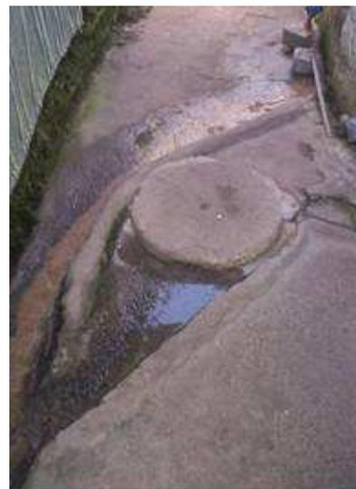
Figura 73: Rua Arsênio Tavares. Ramal coletor obstruído com extravasamento de esgoto.
