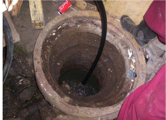
Figura 63: Equipe realizando a desobstrução das tubulações com a mangueira Pead.
