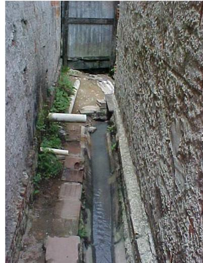
Figura 28: SES Vila Felicidade – Ligação de esgoto no sistema de drenagem (2002).
