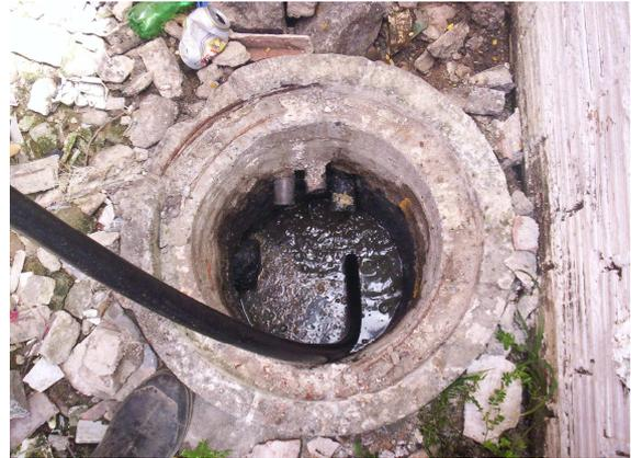
Figura 67: Equipe realizando a desobstrução das tubulações com a mangueira Pead.
