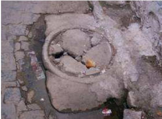
Figura 76: Rua Irmã Ana Brígida. Caixa de inspeção com tampa danificada.
