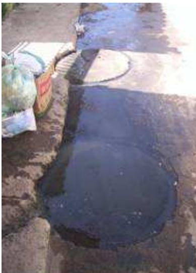
Figura 72: Rua Aurínio Eutíquio da Rocha. Ramal coletor obstruído com extravasamento de esgoto.
