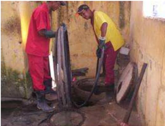
Figura 62: Equipe realizando a desobstrução das tubulações com a mangueira Pead.
