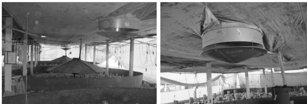
FIGURA 1. Sistema de ventilação mínima por pressão positiva (ventilador). Ventilador posicionado no interior da instalação ao nível do forro, com defletor acoplado, visando evitar a incidência do jato de ar diretamente sobre as aves.
