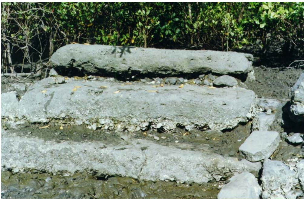
Fig. 18 - Escadaria de Acesso ao Porto de Guarapes. Foto: Cláudia Lago.
