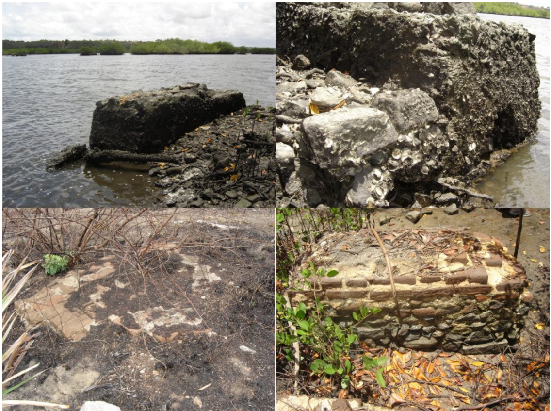
Fig. 22 – Ruínas do porto de Carnaubinha. Além do ancoradouro à beira do rio, encontram-se alicerces de diversas edificações nos arredores. O local contava com uma escola, igreja, diversas residências, escritórios e armazéns.
