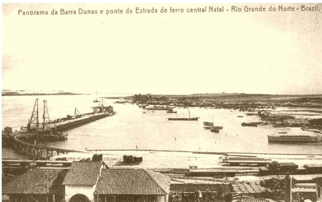
Fig. 50 – Postal das Obras de implantação da ponte de atracação da EFCRGN e da “Barra Dunas”. A interação entre as obras portuárias e ferroviárias na modificação da paisagem é visível nesse postal do início do século XX. Essa ponte seria o futuro atracadouro do porto de Natal, cujos armazéns seriam construídos apenas em 1928, no local do alagadiço onde estão atracadas pequenas embarcações. Já a “Barra Dunas” é a fileira de casas das Rocas que permitiram a fixação das dunas da Limpa. Nesse postal, que pretende propagandar as obras da Estrada de Ferro e da Comissão de Melhoramentos do Porto de Natal, os casebres dos retirantes aparecem como uma importante obra modernizadora da engenharia portuária e não como uma ocupação insalubre e indesejada.
