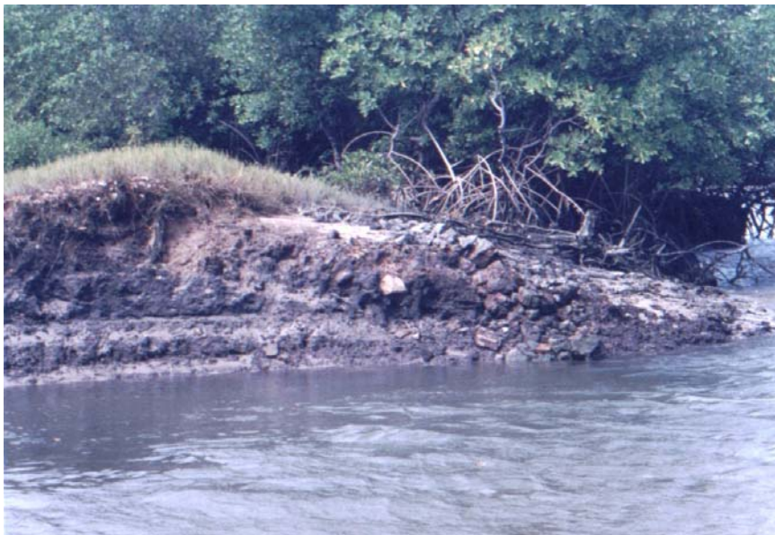
Fig. 14 – Trecho do aterro arreventado, mostrando o perfil da estrutura. Há sobreposições de diferentes tipos de terra, sustentadas pelos muros de pedra. Foto: Leandro Renovato.
