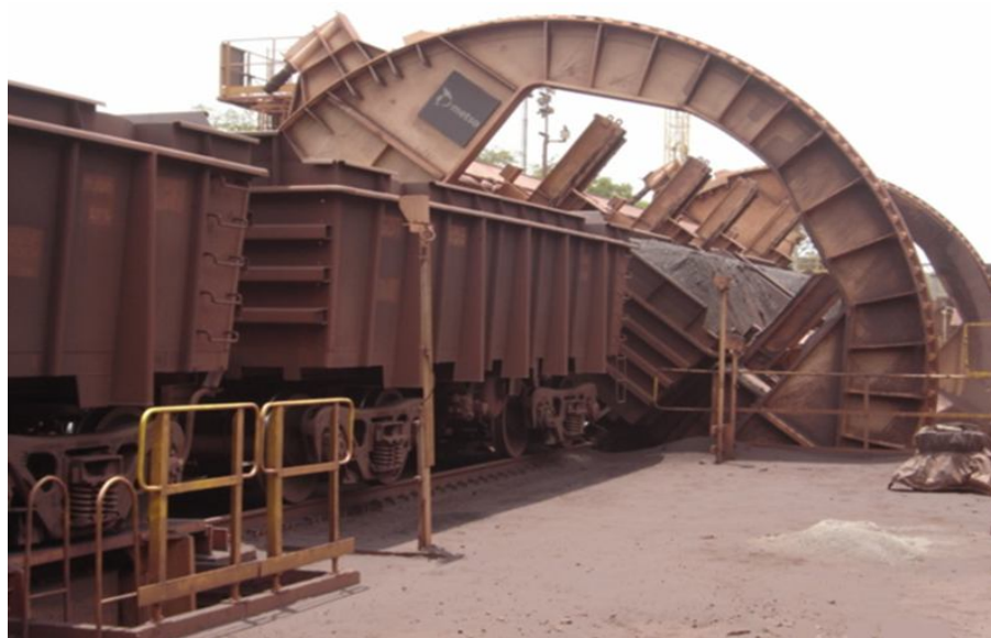
Figura 4 – Estrutura de Giro do VV311-K01.
