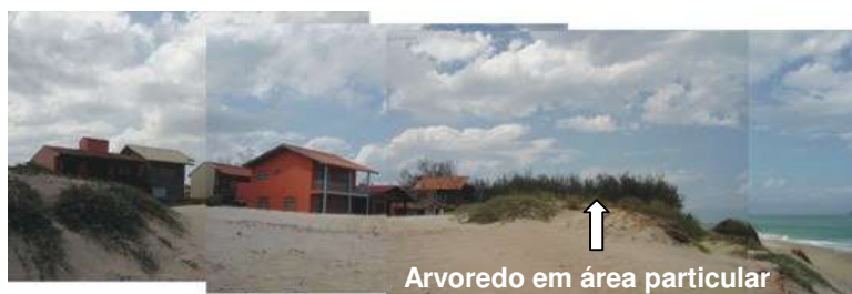
Figura 63: Ocupação urbana sobre as dunas no trecho de Areias.
