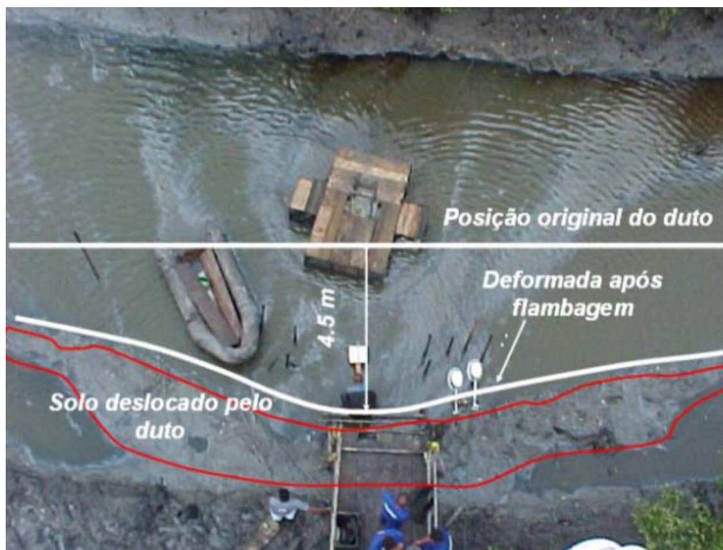
FIGURA 1.1 – DUTO DEFORMADO APÓS FLAMBAGEM
