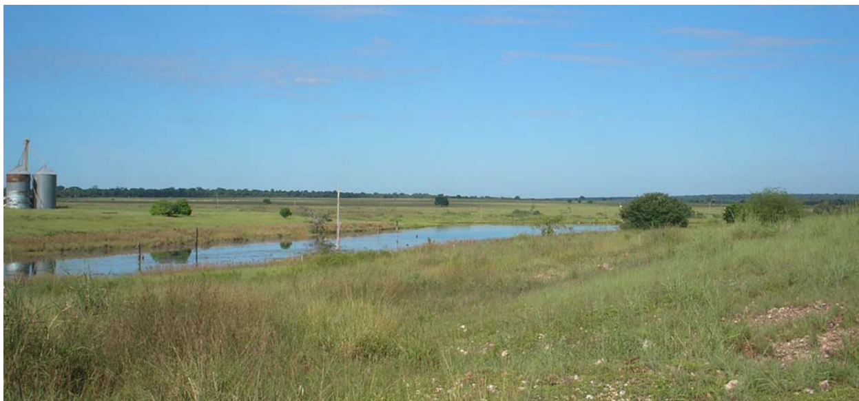
Figura 4. APP 1 em estado avançado de degradação, com perda da cobertura florestal original.
