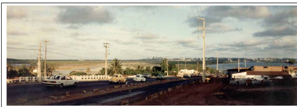
Figura 9: Foto da ponte “nova” de Igapó (durante a execução da obra de sua duplicação). Ano: 1990. Autor: Padre Thiago.
