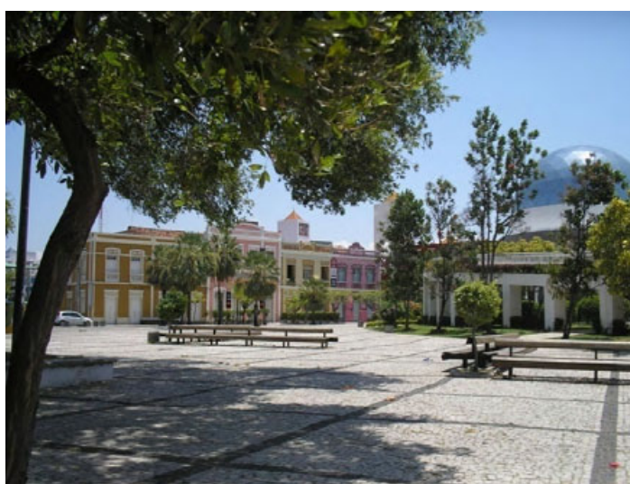
Figura 17. CCDMAC e prédios recuperados pelo Projeto Cores da Cidade Fonte: a Autora
