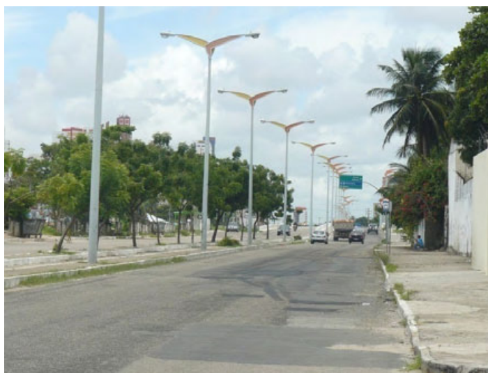
Figura 13. Via Expressa Fonte: Emanuel Cavalcanti
