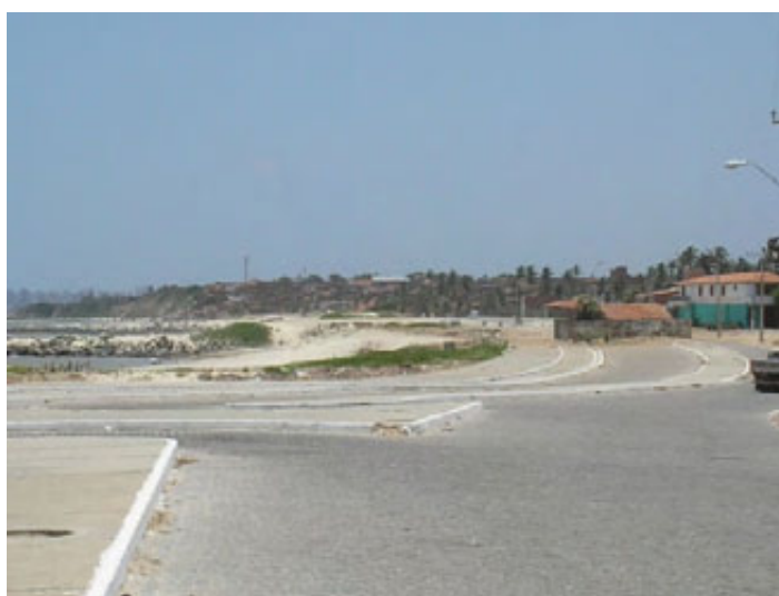
Figura 14. Via Costa Oeste – fim Fonte: a Autora
