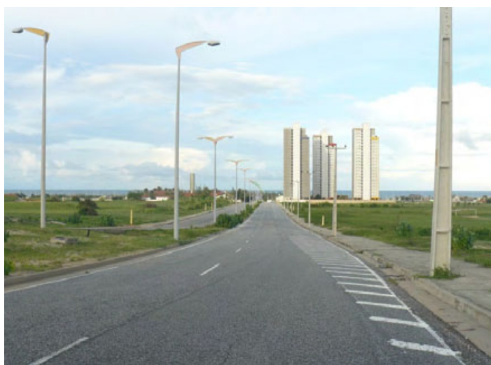
Figura 43. Novos prédios da década de 2000 na Praia do Futuro, às margens da Av. Pe. Anto. Tomaz Fonte: Emanuel Cavalcanti
