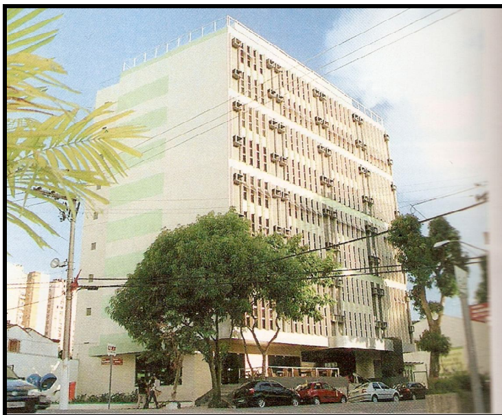
Foto 04 Palácio da Agricultura, atual sede da FAEPA, inaugurada em 08/10/2004. Fonte: Revista Pará Rural (2004).
