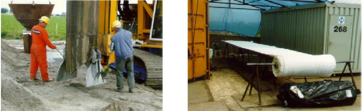
**Figura III. 17– Processo de instalação do geotéxtil nas colunas de areia encamisadas.**
