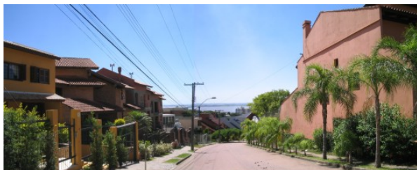
Figura 52 - VISTA 02 (permeável x impermeável) – Rua José O. Mânica - condomínio Puerto Escondido
