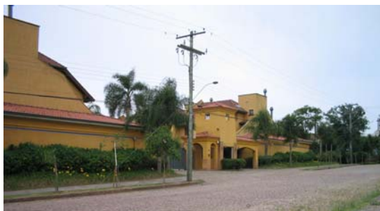
Figura 23 – Rua 14 de Julho - acesso
