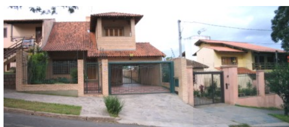
Figura 92 – VISTA 04 (fachada permeável) – Rua Mutualidade - proximidades Puerto Escondido
