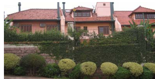
Figura 50 - VISTA 05 (fachada impermeável) - , Rua Aismos Aiquel - condomínio Alameda França
