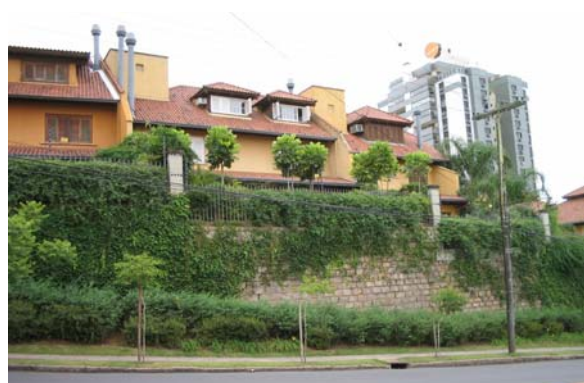
Figura 22 - Trecho da barreira funcional e visual do condomínio Paradiso - rua Marechal Andréa.
