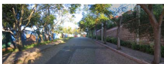
Figura 86 - VISTA 03 (impermeável x impermeável) Rua Aismos Aiquel - condomínio Alameda França
