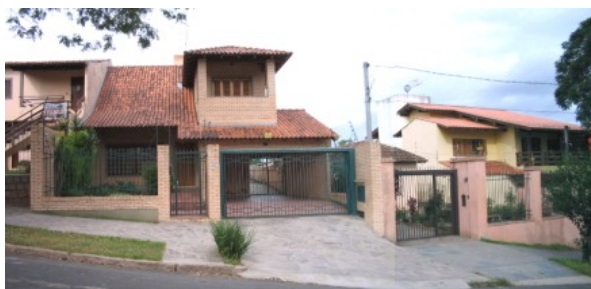
Figura 54 – VISTA 04 (fachada permeável) – Rua Mutualidade – proximidades condomínio Puerto Escondido
