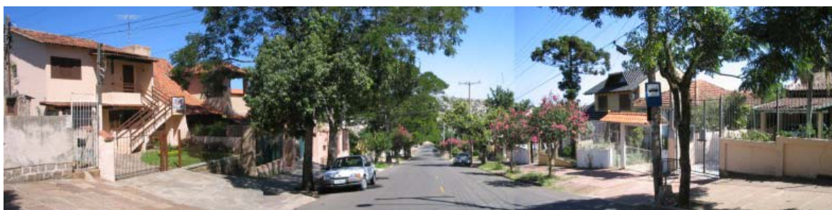
Figura 51 - VISTA 01 – (permeável x permeável) - Rua Mutualidade – Rua selecionada nas proximidades do condomínio Puerto Escondido
