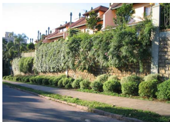
Figura 73 – Trecho da barreira física – condomínio Alameda França.
