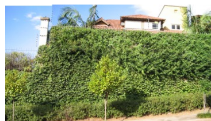
Figura 45 – VISTA 05 (fachada impermeável) – Rua Prof. Romano Reif - condomínio Paradiso
