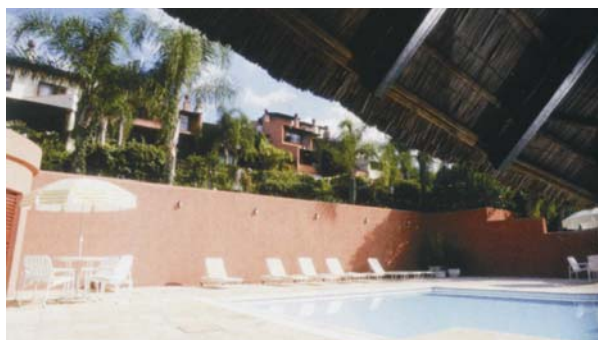
Figura 67 – Vista da área da piscina do condomínio Puerto Escondido. Fonte: Revista Ambiente, nº 83.
