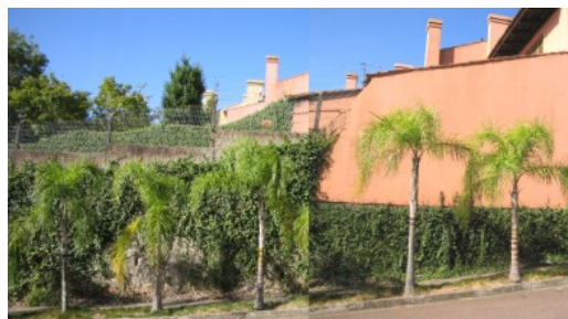
Figura 55 – VISTA 05 (fachada impermeável) – Rua José O. Mânica – condomínio Puerto Escondido
