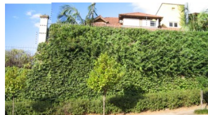
Figura 83 – VISTA 05 (fachada impermeável) – Rua Prof. Romano Reif - condomínio Paradiso
