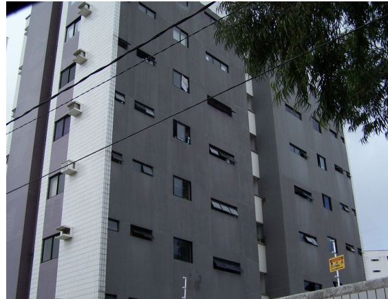
Foto 13 – Fachada Posterior do edf. Ville de Montpellier. Foto do autor (2006).
