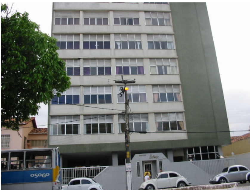
Foto 05 - Edifício Salmar. Construído em 1969 – foto do autor(2005).
