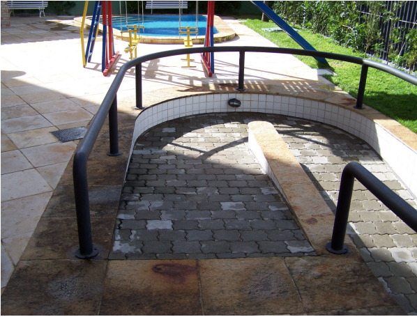
Foto 20 – Rampa de acesso ao à área comum do edifício. Foto do autor (2006)
