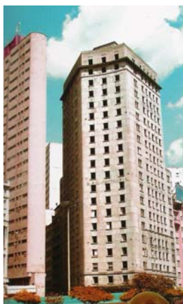
Figura 32: Antigo “Hotel São Paulo”, hoje mais um conjunto do PAR chamado “Edifício São Paulo”
