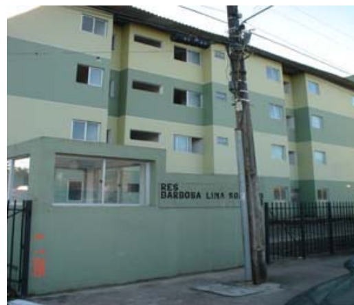
Figura 25: Entrada do conjunto Residencial Barbosa Lima Sobrinho
