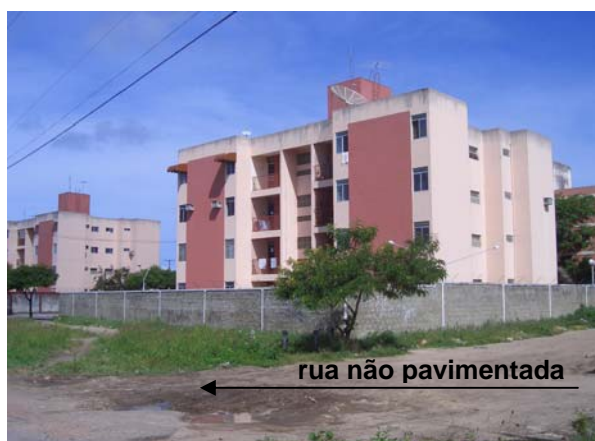
Figura 48: Vista dos edifícios do conjunto Mangabeira Portal do Seixas, em Mangabeira (região sudeste)
