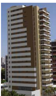
Figura 100: Edifício Dom João, localizado no bairro de Manaíra e construído pela “RD Incorporações” Fonte: Site da RD (2006)
