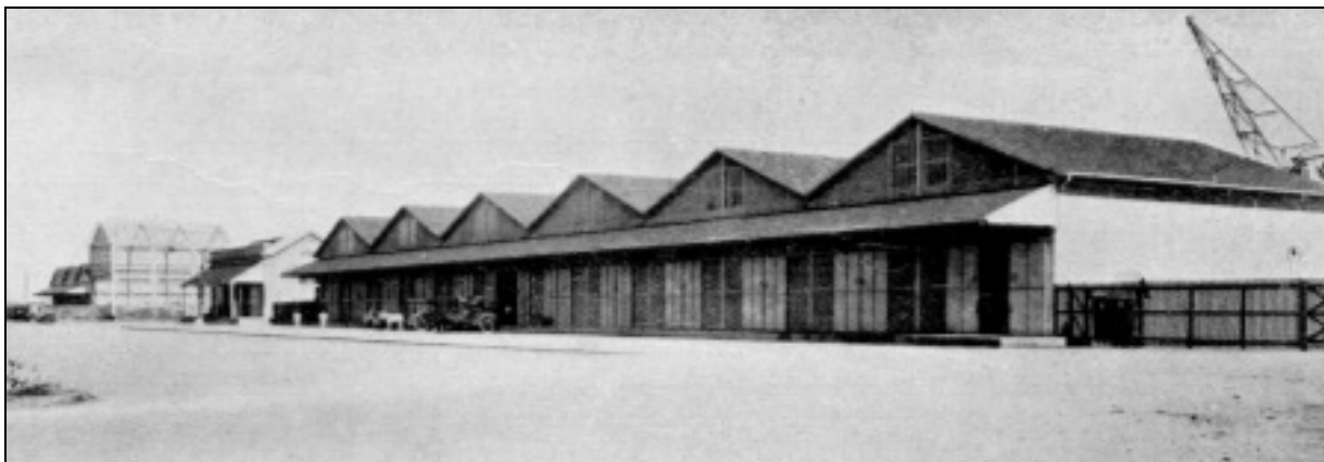
Fig. 32: Armazéns do cais com o Portão Central em fase de montagem ao fundo. Fonte: acervo GEDURB
