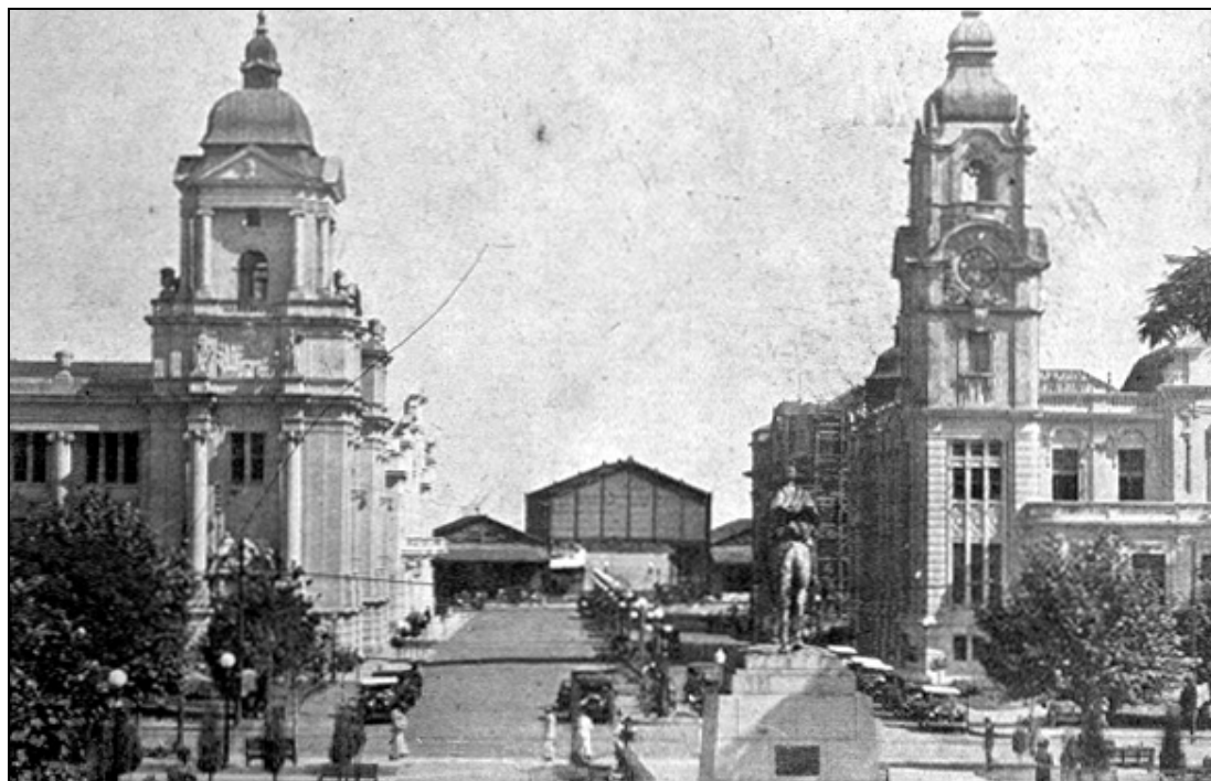
Fig. 16: Avenida Sepúlveda com os prédios da Delegacia Fiscal e dos Correios e Telégrafos. Fonte: arquivo GEDURB
