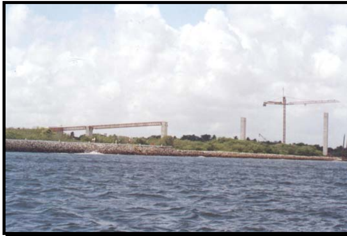
Figura 6.7 - Enrocamento do tipo rip-rap abrigado, disposto na margem para conter a erosão no segmento 07 (ISL 8), localizado na margem direita da foz do rio Potengi (Foto: Frazão, nov. 2001).
