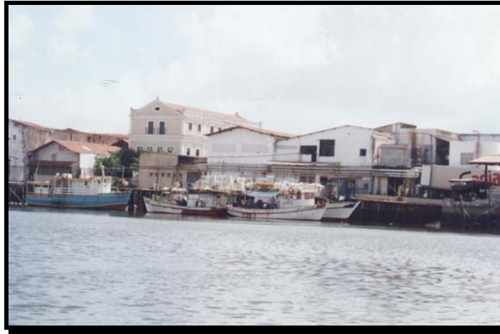
Figura 6.9 - Segmento com ISL 1, apresentando instalações das indústrias pesqueiras, onde foram construídas, ao longo da margem, várias estruturas artificiais como os piers (Fotos: Frazão, nov. 2001).
