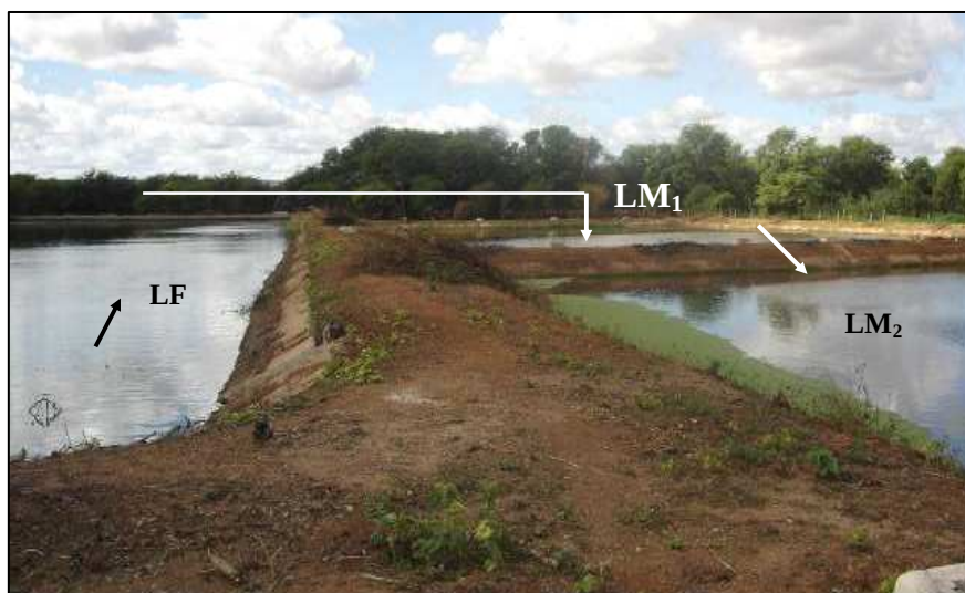
Figura 2 - Estação de Tratamento de Esgoto de Petrolândia (uma lagoa facultativa seguida de duas de maturação).
