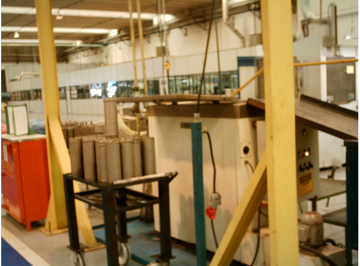
Figura 17 – Tanque de limpeza química dos anéis.
