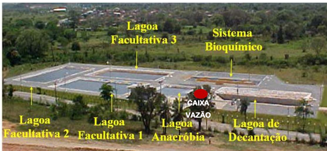
FIGURA 16. Ponto de coleta do lixiviado da estação de tratamento de lixiviado do Aterro da Muribeca.
