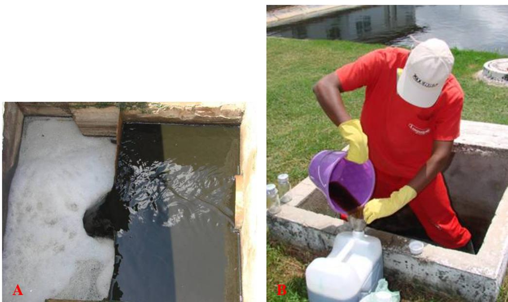
FIGURA 17. A) Caixa de vazão da estação de tratamento de lixiviado da Muribeca. B) Coleta das amostras de lixiviado.
