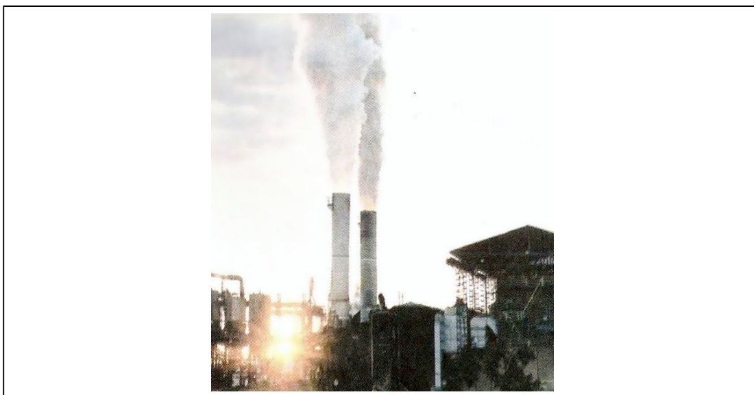
Figura 19: Sistemas de geração de vapor – Caldeiras da Jalles.
