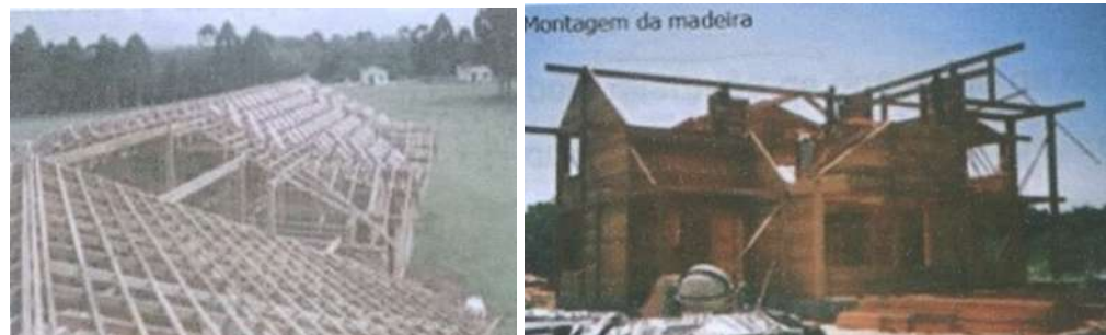
Figura 92 – Montagem do madeiramento. Fonte: Block-Haus, 2008.
