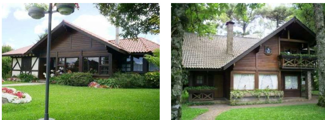
Figura 94 – Projetos personalizados. Fonte: Block-Haus, 2008.
