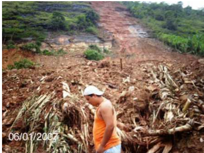
Figura 6 – Afetado desolado passa por área deslizada (PREFEITURA MUNICIPAL DE SUMIDOURO, 2007).
