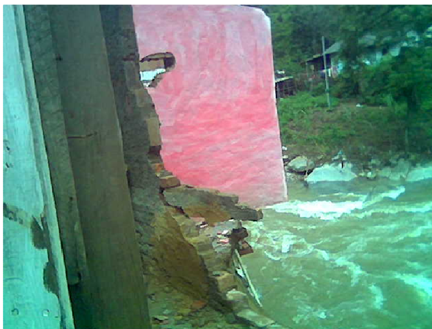
Figura 14 – Única parede que restou da casa que foi levada pelo rio. Distrito de Riograndina (Acervo NEPED, 18 jan. 07).
