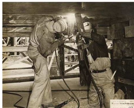
Fig. 1.1 soldadores usando eletrodo revestido na soldagem de casco de navio.
