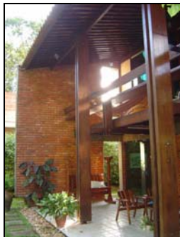
Foto 03 – Varandas. Fachada Sul.
