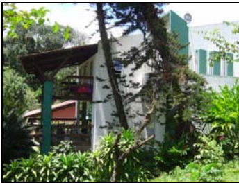
Foto 03 – Parcial Fachada Oeste.
