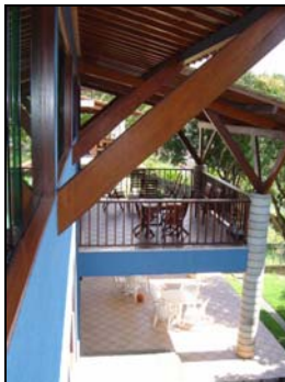
Foto 04 - Beiral e varandas da Fachada Leste.
