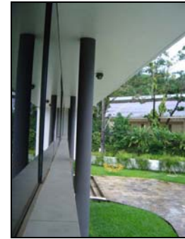
Foto 3 - Beiral da Fachada Sudeste.
