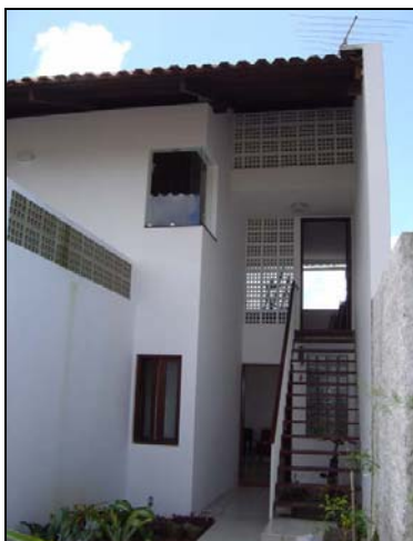
Foto 107: Casa U1.1 – Peitoril da varanda e atelier. Fachada Sudoeste.
