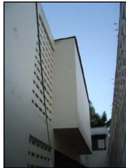
Foto 3 - Parcial Fachada Oeste.
