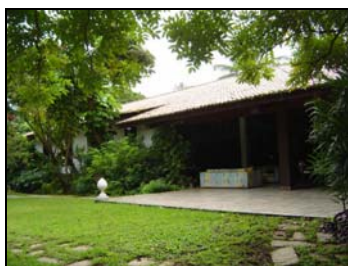
Foto 2 - Parcial Fachada Leste. Varanda.
