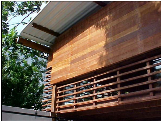
Foto 89: Casa U1.1 – Beiral. Parcial Fachada Oeste.
