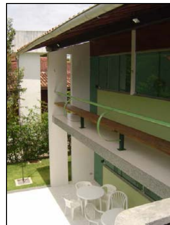
Foto 54: Casa C.9 – Calha de PVC. Parcial Fachada Nordeste.
