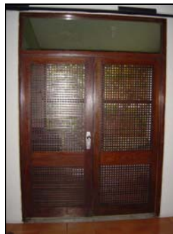
Foto 4 - Esquadria treliçada de madeira.
