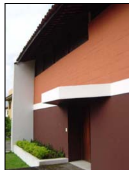
Foto 2 - Parcial Fachada Noroeste.
