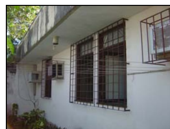
Foto 02 - Parcial Fachada Leste.
