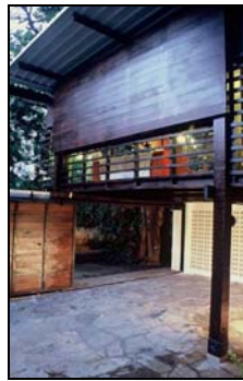
Foto 2 - Parcial Fachada Oeste.
