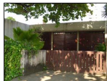
Foto 01 - Parcial Fachada Oeste.
