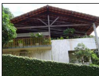
Foto 2 – Parcial Fachada Sul. Varanda.
