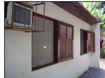
Foto 4 - Trecho da Fachada Sul.
