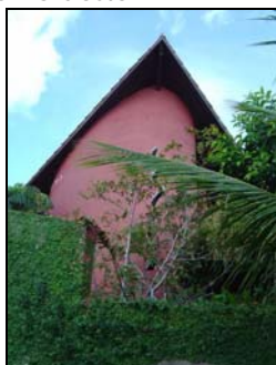
Foto 3 - Parciais Fachadas Noroeste e Sudoeste.
