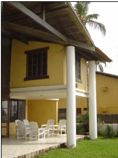
Foto 86: Casa P.2 - Varanda no pavimento térreo. Parcial Fachada Sudeste.
