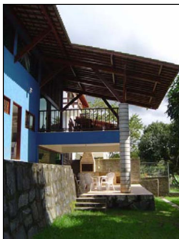
Foto 82: Casa U2.12 – Varandas. Parcial Fachada Leste.
