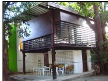
Foto 5 - Parciais Fachadas Leste e Norte.
