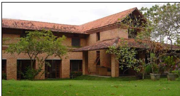
Foto 34: Casa C.5 – Aldeia, Camaragibe.
