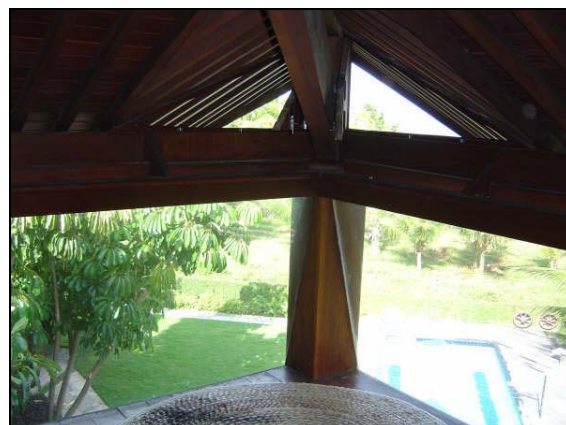
Foto 140: Casa P.10– Suite do casal. Janela de madeira com peitoril de vidro fixo. Integração visual com o jardim e a paisagem da praia.
