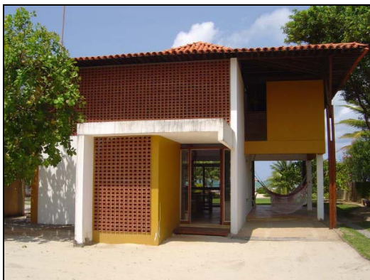
Foto 117: Casa P.9 – Fachada Oeste. Cozinha e depósito com parede de cobogó.
