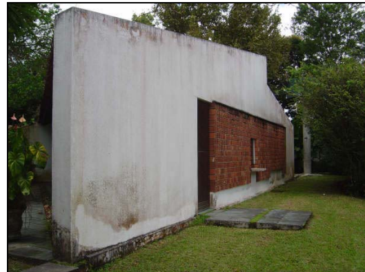
Foto 114: Casa C.10 – Fachada Oeste. Tijolos assentados transversalmente à direção da parede.
