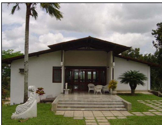
Foto 101: Casa C.8 – Jardim gramado com palmeiras. A vegetação não gera sombreamento na edificação.
