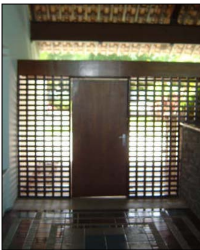
Foto 115: Casa P.3 – Hall com orientação oeste. Parede treliçada de madeira.
