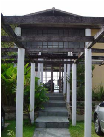
Foto 94: Casa P.2 – Esquadria de madeira e vidro e beiral. Parcial Fachada Noroeste.
