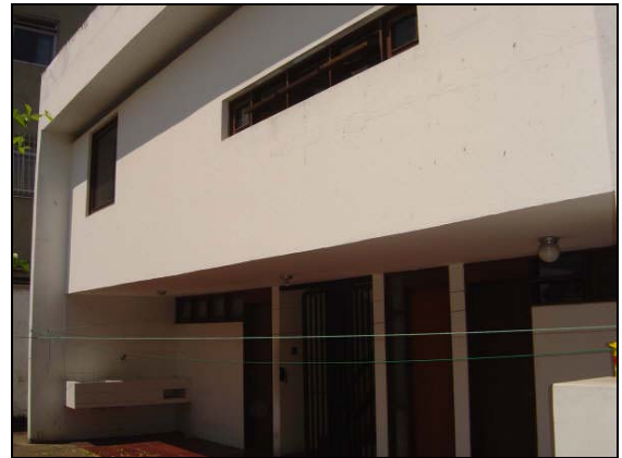
Foto 90: Casa U1.9 – Beiral. Parcial Fachada Oeste.
