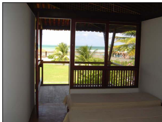
Foto 138: Casa P.9 – Quarto dos filhos. Esquadria mista: madeira e vidro, com a parte inferior em veneziana móvel. Acesso à varanda e integração visual com o jardim e a paisagem da praia.
