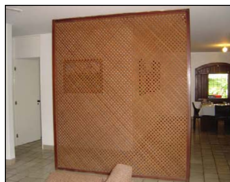
Foto 112: Casa U2.8 – Divisória treliçada de madeira entre as salas de jantar e TV.
