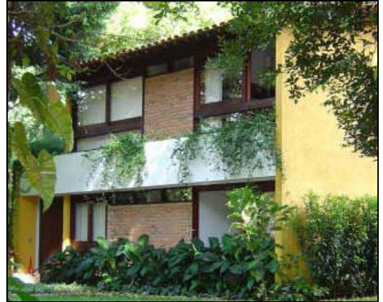
Foto 93: Casa C.1 – Beiral, jardineira e proteção vertical nas extremidades da Fachada Sul.
