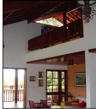
Foto 73: Casa U2.3 - Abertura na empena, junto à cumeeira. Fachada Leste.
