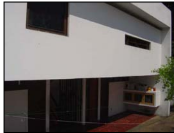
Foto 3 - Parcial Fachada Oeste.
