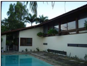
Foto 2 - Parciais das Fachadas Norte e Leste.
