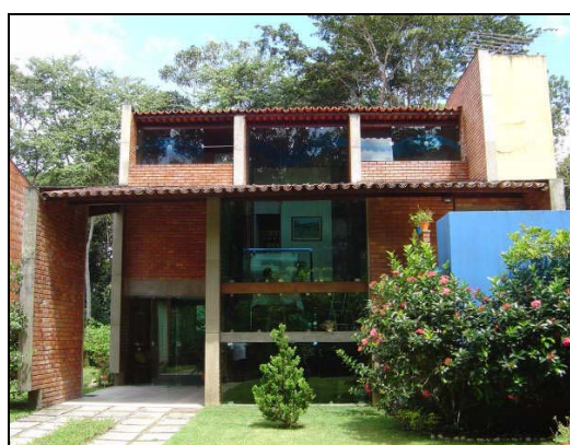
Foto 36: Casa C.7 – Aldeia, Camaragibe.
