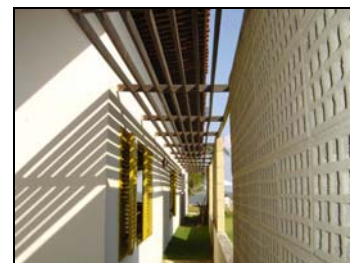
Foto 5 - Proteção solar da Fachada Sudoeste.
