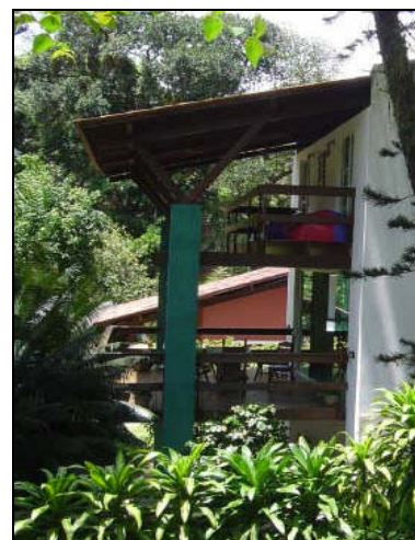
Foto 83: Casa U2.14 – Varandas. Parcial Fachada Oeste.
