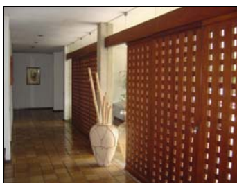
Foto 08 - Esquadria treliçada de madeira.
