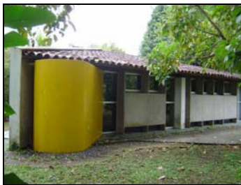
Foto 03 - Parcial Fachada Sudeste.
