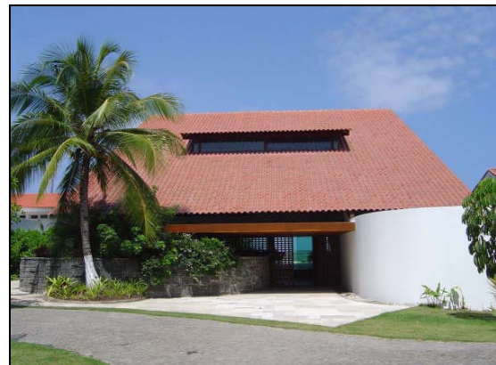
Foto 70: Casa P.3 – Telha cerâmica sobre madeiramento. Água furtada sobre a sala. Fachada Oeste.
