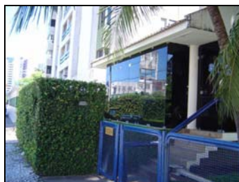
Foto 3 - Parciais Fachadas Leste e Norte.
