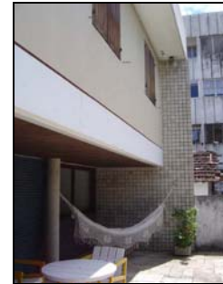
Foto 05 - Parcial Fachada Sudoeste.
