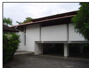
Foto 3 - Parcial Fachada Oeste. Shed para a iluminação e ventilação dos WC's das suítes
