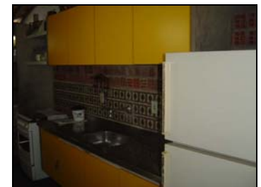
Foto 11 - Cozinha. Parede oeste vazada.
