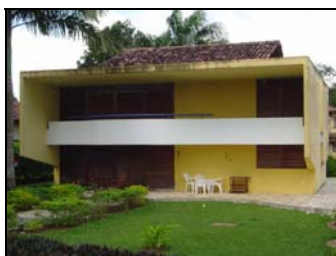
Foto 01 - Fachada Leste. Protetores verticais nas extremidades das varandas.
