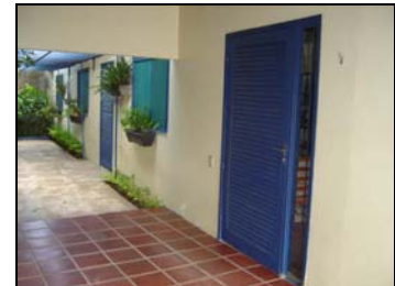
Foto 3 - Varanda e parcial da Fachada Sudoeste.
