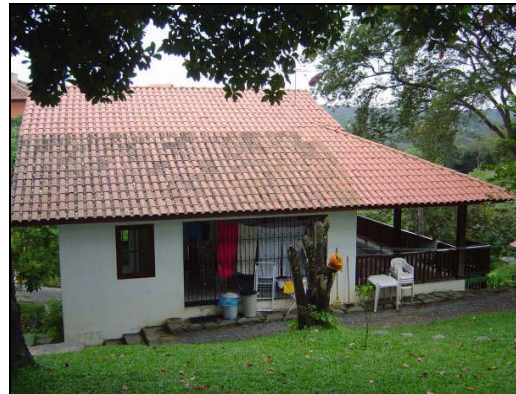
Foto 68: Casa U2.3 – Telha cerâmica sobre madeiramento. Fachada Sul.
