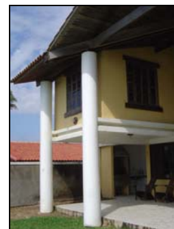
Foto 5 - Varanda e beiral da Fachada Sudeste.
