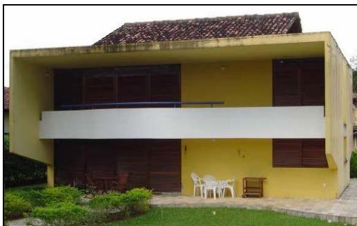
Foto 74: Casa C.6 - Telha cerâmica sobre madeiramento + Laje impermeabilizada. Fachada Leste.
