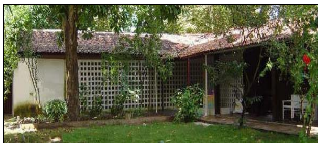
Foto 24: Casa U2.9 – Poço da Panela, Recife.
