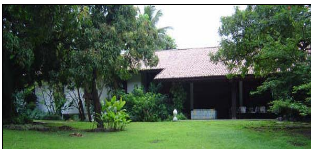
Foto 25: Casa U2.10 – Poço da Panela, Recife.
