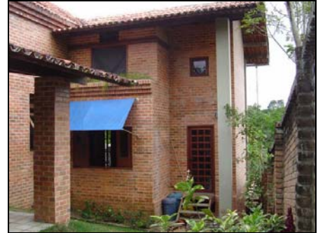
Foto 55: Casa C.5 – Janela da copa.
