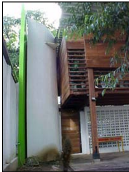
Foto 4 - Parcial Fachada Leste
