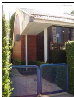
Foto 2 - Parciais Fachadas Leste e Sul.
