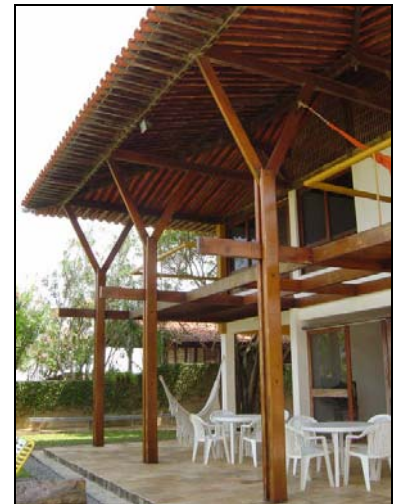
Foto 88: Casa P.9 - Varandas dos dois pavimentos. Parcial Fachada Leste.
