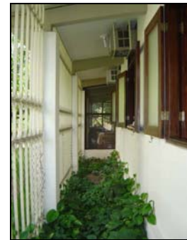
Foto 3 - Beiral apoiado em pilares.
