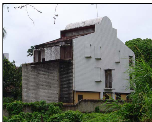
Foto 110: Casa U2.7 – Fachadas Noroeste e Sudoeste. Lanternin e “Muxarabi” de cobogó.
