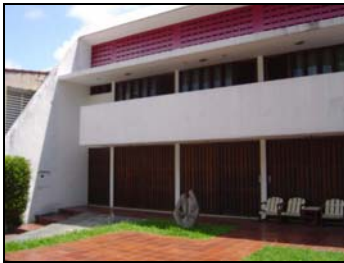
Foto 2 - Parcial Fachada Leste.
