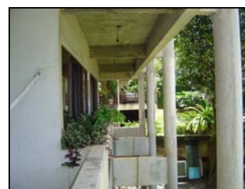
Foto 8 – Balanço da varanda superior protege as janelas dos quartos.
