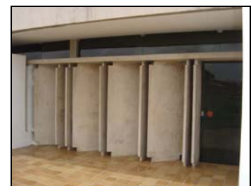
Foto 04 - Parede vazada da circulação dos quartos.
