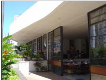
Foto 1 - Parcial Fachada Leste.
