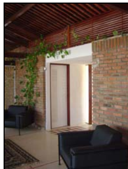
Foto 3 - Estar. Janela alta taliscada de madeira.
