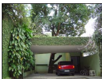
Foto 1 – Parcial Fachada Sul. Garagem.
