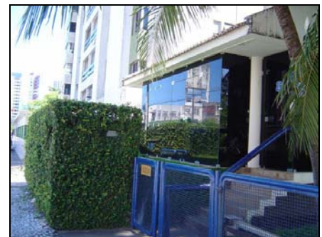
Foto 59: Casa U1.5 – Varanda do pavimento térreo totalmente vedada com esquadrias de vidro.
