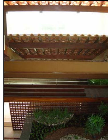
Foto 61: Casa P.3 – Água furtada vedada com vidro.
