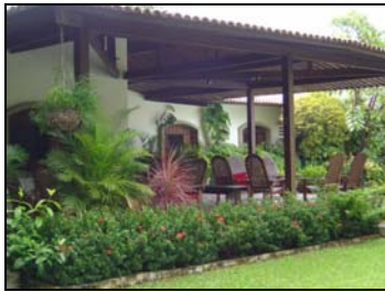
Foto 1 - Parcial Fachada Sudeste.
