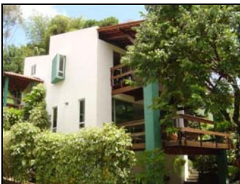
Foto02 – Parciais das Fachadas Leste e Norte.
