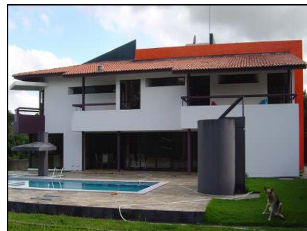
Foto 31: Casa C.2 – Aldeia, Camaragibe.
