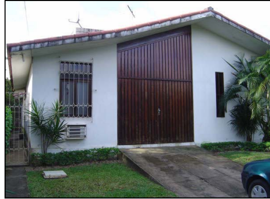
Foto 67: Casa U1.3 – Telha cerâmica sobre laje inclinada. Parcial Fachada Sudoeste.
