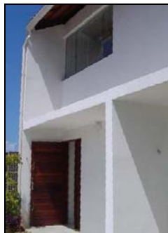
Foto 4 - Parcial Fachada Nordeste. Terraço.
