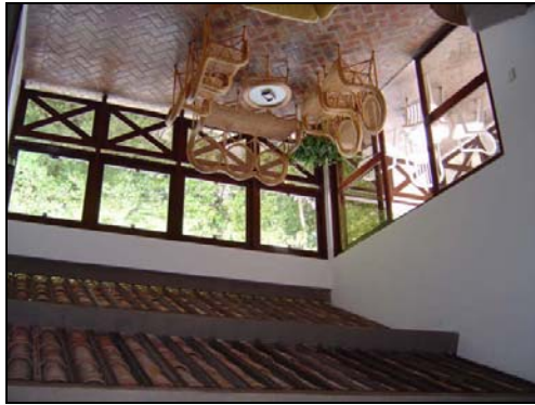
Foto 60: Casa U2.4 – Esquadria da sala. Vedação da faixa horizontal central com vidro.
