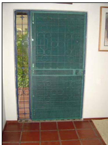
Foto 63: Casa U1.8 – Porta de acesso entre a varanda e a sala. Todas as aberturas da casa foram teladas.
