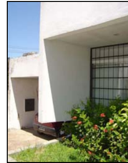
Foto 3 - Protetor vertical e beiral. Fachada Leste.
