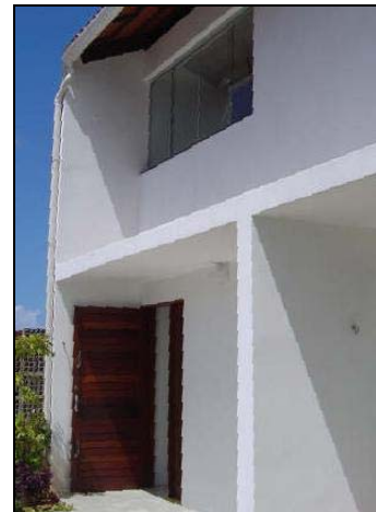
Foto 51: Casa U1.1 – Calha de PVC. Parcial Fachada Nordeste.
