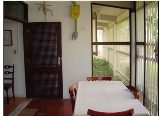
Foto 62: Casa U1.3 – Todas as aberturas da casa foram teladas, inclusive a varanda.
