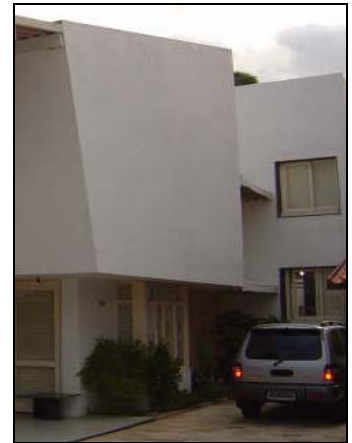
Foto 58: Casa P.7 – Paredes de cobogó da sala.
