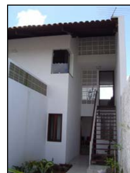
Foto 3 - Parcial Fachada Sudoeste. Hall de entrada.
