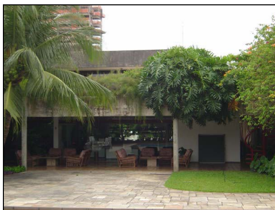
Foto 14: Casa U1.10 - Torreão, Recife.
