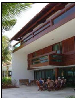
Foto 3 - Varandas. Fachada Leste.
