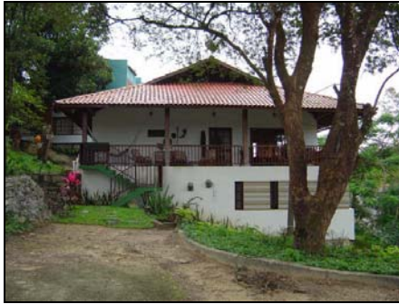
Foto 72: Casa U2.3 - Telha cerâmica sobre madeiramento. Fachada Sul.
