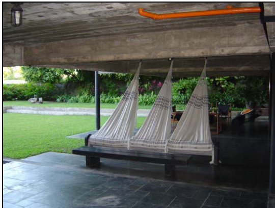
Foto 78: Casa U1.6 – Pavimento térreo. Fachada Sudeste.
