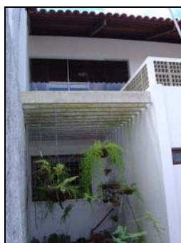
Foto 2 - Parcial Fachada Sudoeste.
