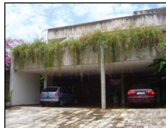
Foto 2 - Parcial Fachada Noroeste.
