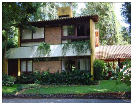
Foto 30: Casa C.1 – Aldeia, Camaragibe.
