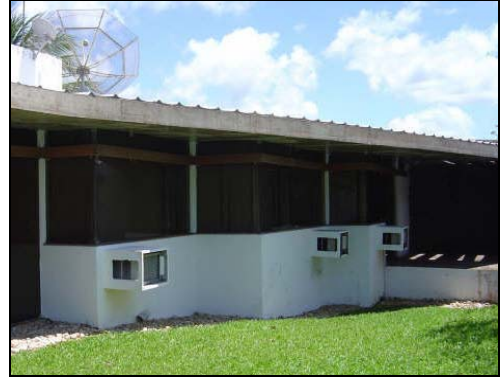
Foto 50: Casa U2.13 – Cobertura metálica sobre laje impermeabilizada.
