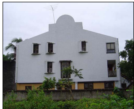
Foto 92: Casa U2.7 – Protetores verticais e horizontais. Fachada Sudoeste.
