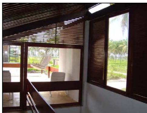
Foto 132: Casa P.1 - Mezanino. Esquadria de madeira e vidro com bandeira vazada. Acesso à varanda e integração visual com o entorno.
