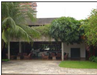
Foto 1 - Parcial Fachada Sudeste.
