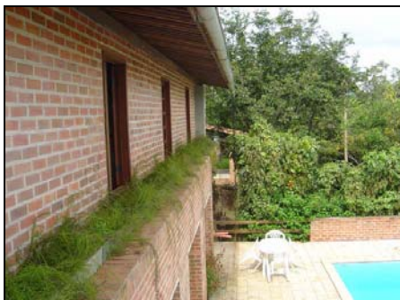
Foto 53: Casa C.5 – Calha de PVC. Parcial Fachada Nordeste.
