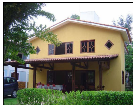
Foto 33: Casa C.4 – Aldeia, Camaragibe.
