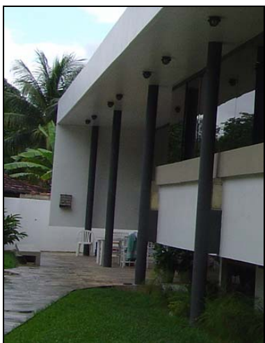
Foto 81: Casa U2.2 – Varanda. Parcial Fachada Sudeste.
