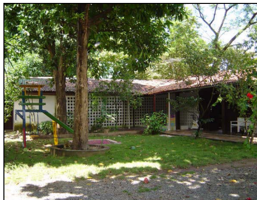
Foto 100: Casa U2.9 – Árvores adultas sombreiam as fachadas: Leste, Norte e Sul.
