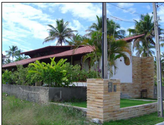
Foto 76: Casa P.1 – Telha cerâmica sobre madeiramento. Fachadas Nordeste e Sudoeste.
