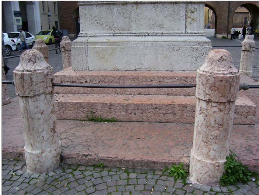
FIGURA 11. Geração de relevos e cavidades devido a diferenças de resistência entre matriz carbonática e fragmentos bioclásticos. Base da escultura de Girolamo Savoranola (Ferrara – Itália)
