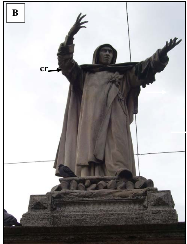
FIGURA 16. Patologias em rochas calcárias. (A) Desenvolvimento de fissuras (fs) e fraturas (fr) conectadas em calcário usado como piso externo. (B) Crostas negras (cr) desenvolvidas nas áreas protegidas da lavagem por chuva, estátua de Girolamo Savonarola (Ferrara).
