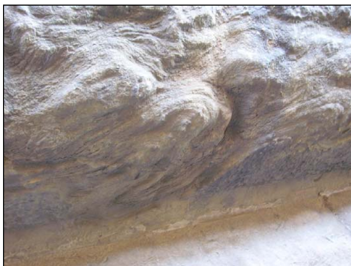
FIGURA 9. Estratificação convoluta típica do arenito Pietraforte (arenito com matriz calcária). Palazzo Strozzi (Florença – Itália).
