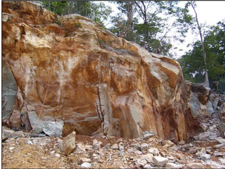
FIGURA 23. Nível intermediário (produtivo) na lavra de calcário Royal Verde. Observa-se o grau de fraturamento com fraturas e diáclases de alto ângulo.
