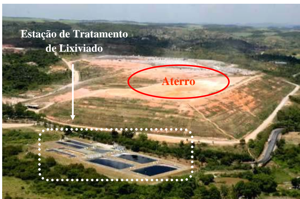
Figura 3.1. Vista aérea do Aterro da Muribeca e a da Estação de Tratamento de Lixiviado.
